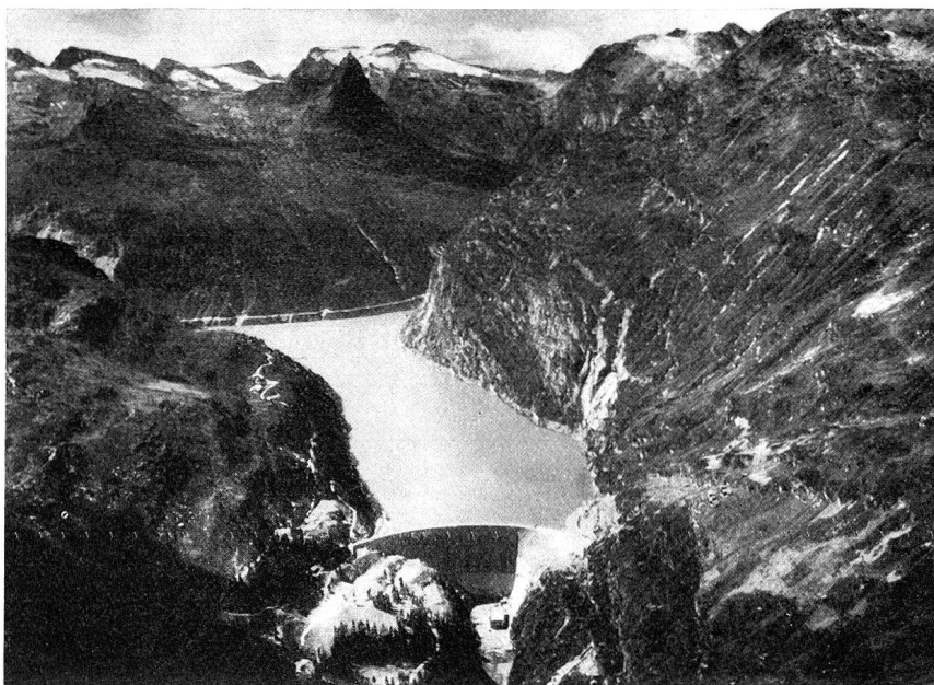
Der Zervreila-Stausee, den unser Bild zeigt, stellt nicht nur das jüngste Staubecken der Schweiz dar, sondern zugleich auch die erste Großakkumulieranlage im Kanton, die in den letzten Jahrzehnten entstanden ist. Das grandiose technische Werk wurde jüngst eingeweiht. Die Mauer weist eine maximale Höhe von 152 m auf und eine Kronenlänge von 483 m. Sie dient dem Aufstau von 100 Millionen m 3 Wasser. Zugleich bildet sie die Vorläuferin einer Anzahl weiterer Staumauern, an denen gegenwärtig im Kanton intensiv gearbeitet wird.
