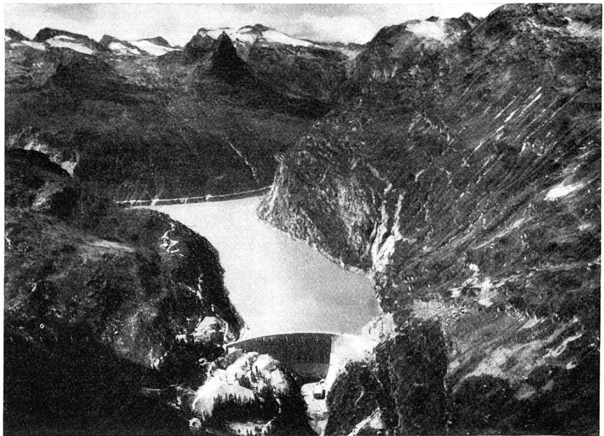
Der Zervreila-Stausee, den unser Bild zeigt, stellt nicht nur das jüngste Staubecken der Schweiz dar, sondern zugleich auch die erste Großakkumulieranlage im Kanton, die in den letzten Jahrzehnten entstanden ist. Das grandiose technische Werk wurde jüngst eingeweiht. Die Mauer weist eine maximale Höhe von 152 m auf und eine Kronenlänge von 483 m. Sie dient dem Aufstau von 100 Millionen m 3 Wasser. Zugleich bildet sie die Vorläuferin einer Anzahl weiterer Staumauern, an denen gegenwärtig im Kanton intensiv gearbeitet wird.
