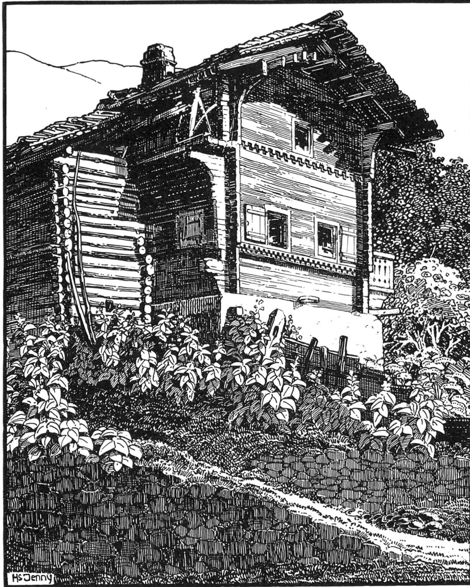
Eingemachiges Bauernhaus in Tschiertschen (Schanfigg). Nach Zeichnung (Alte Bündner Bauweise und Volkskunst II, Fig. 128)
