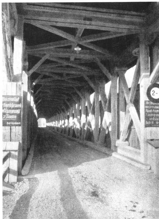
Blick durch das Innere der alten Brücke
