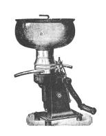
Modell 1913, für Hand- und Kraftbetrieb, ist heute unbestritten dievervollkommnetste und beste Milchzentrifuge der Welt. Sie zeichnet sich namentlich aus durch sehr exakte, solide und einfache Konstruktion, schärfste Entrahmung, große Dauerhaftigkeit und spielend leichten, geräuschlosen Gang. Seit 30 Jahren hat sich der Alfa-Separator von allen andern Milchzentrifugen in der Praxis am besten bewährt.
