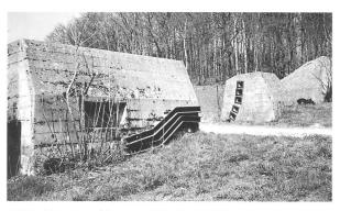
172 Wegdurchlass mit Zugschienensperre. Foto 1987.
