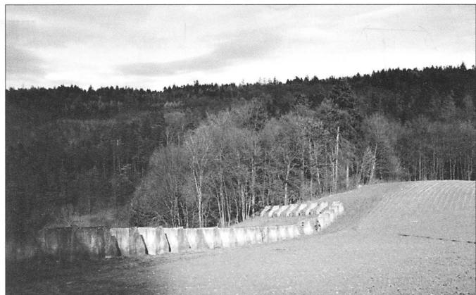
176 Teilstück Gebenstorf Steig, 44 Blöcke, zwei Wegdurchlässe. Abgebrochen. Foto 1987.
