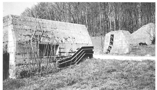
172 Wegdurchlass mit Zugschienen Sperre. Foto 1987.
