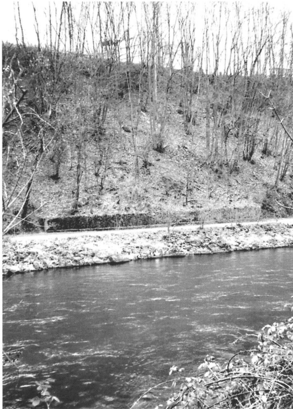
159 Die Stützmauer, vom andern Limmatufer aus gesehen. Oben auf der Kante verläuft die Eisenbahnlinie. Foto 1998.
