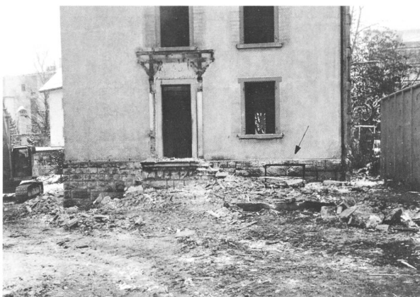
167 Das Haus Bruggerstrasse 84, das letzte vor der Martinsbergfelsnase. Im Sockel war die Scharte für die Infanteriekanone ausgebrochen worden. Foto 1995.
