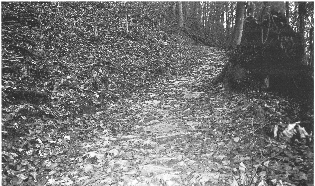
157 Ein Stück des Fussweges, der mit grossen, aus einem Steinbruch zugeführten und hier solid verlegten Kalkbrocken befestigt ist.
