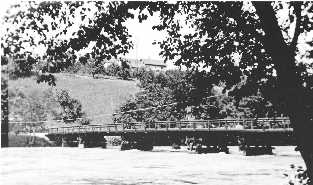
139 Die im Dezember und Januar 1939/40 gebaute Holzbrücke über die Reuss. Blick gegen die Birmenstorfer Seite. Der Fluss hat Hochwasser. Am Drahtseil kann eine Wagenfähre eingehängt werden, für die auch Zufahrten vorbereitet sind.
