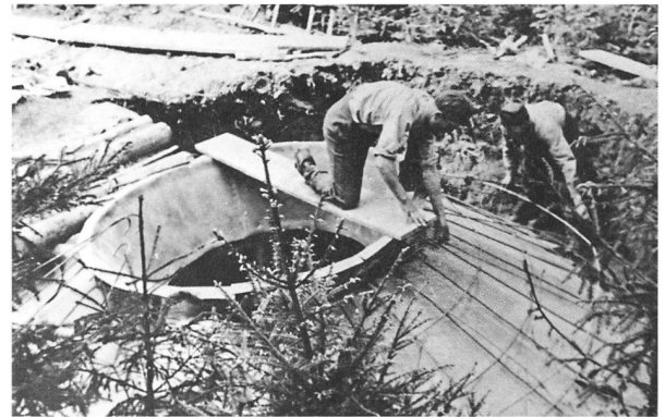
40 Armierter Beton verstärkt die Decke.
