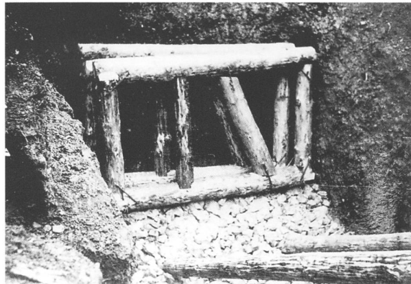
33 Drei Rahmen in der Baugrube; vorn die Gleitbahn.
