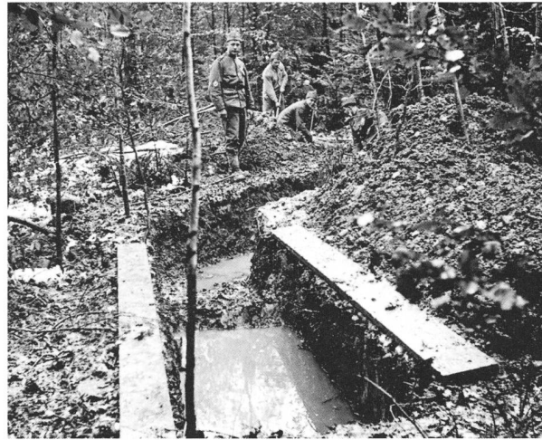
46 Heikler Bau: Das Wasser muss abgeleitet werden.
