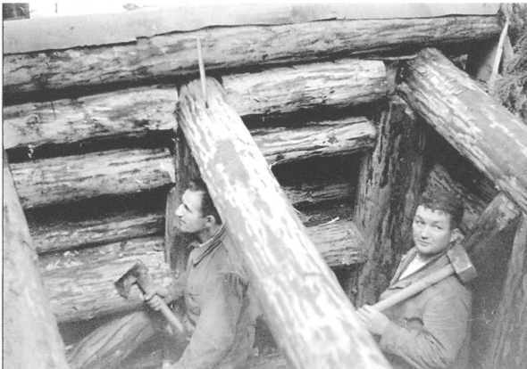
34 Bauteil eines Waffenstandes vor der Überdeckung.
