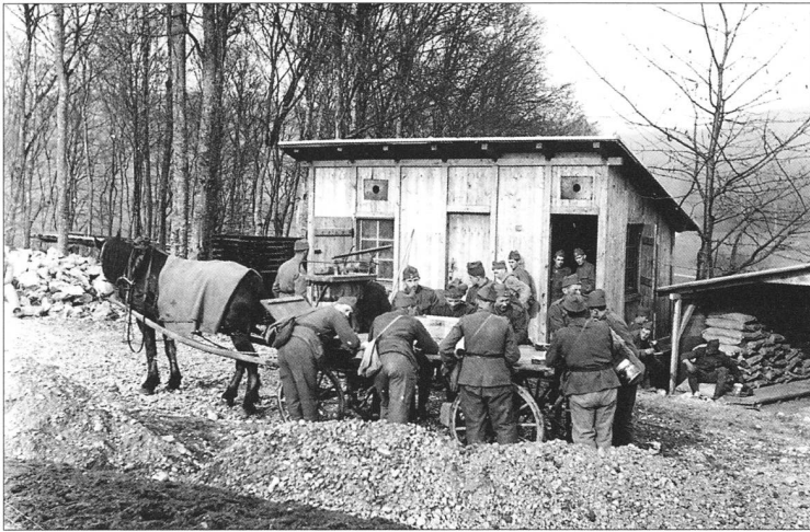
70 Der Mittagstisch braucht nicht komfortabel zu sein. Hauptsache ist, dass die Verpflegung zeitgerecht eintrifft, warm und reichlich ist. Hinten steht die Materialbaracke Schaubiger.
