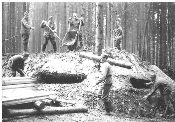
36 Fertig überdeckter Waffenstand mit 2 Scharten.
