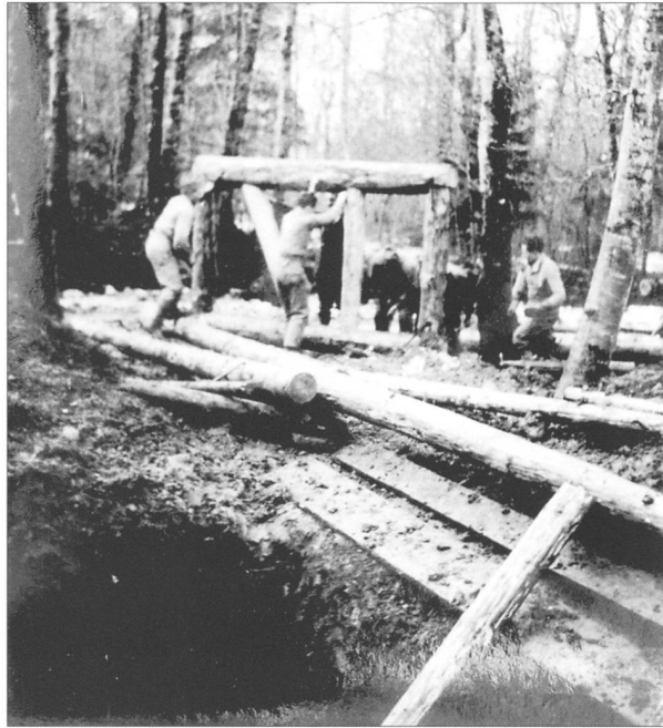
32 Zusammenbau der Rahmen am Abbindplatz.
