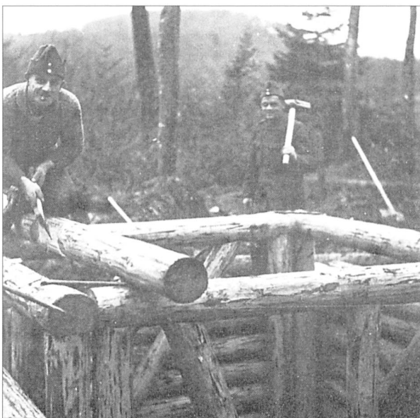
35 Waffenstand. Der Deckenaufbau beginnt.
