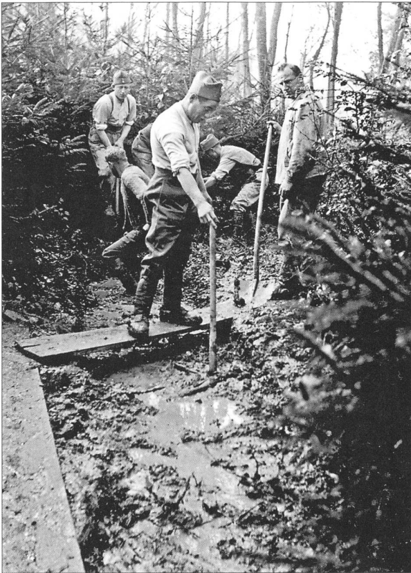
45 Baubeginn für den Verbindungsgraben der vier Mw.
