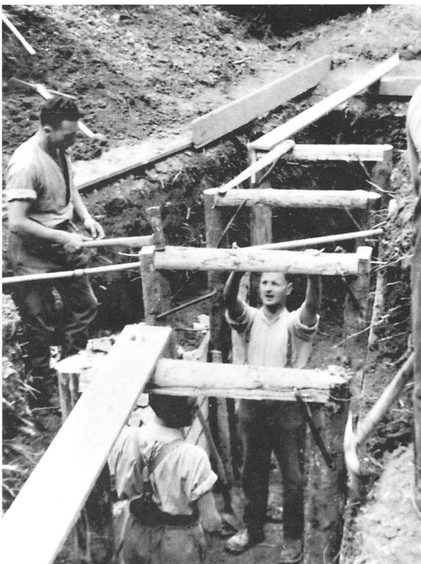
47 Stabilisierung der Wände; Beginn der Decke.
