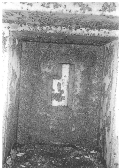
61 Industriell geschnittene Öffnung beim Ik.-Bunker Obere Kehlstrasse. Foto 2012.
