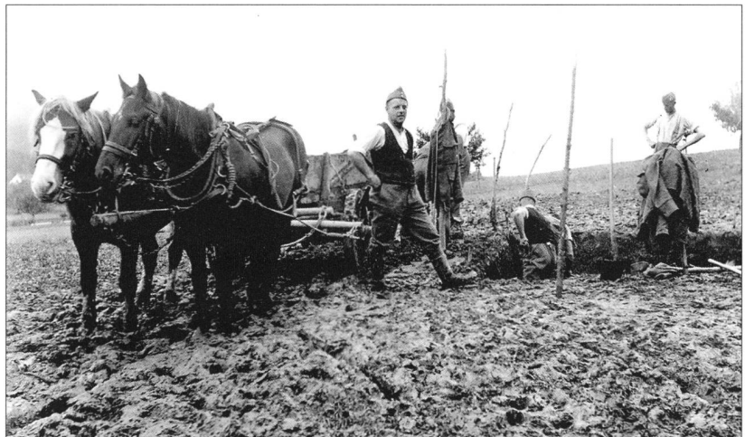
68 Spatenstich beim unteren der beiden Bunker für zwei Maschinengewehre.
