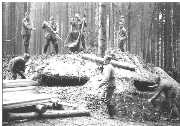
36 Fertig überdeckter Waffenstand mit 2 Scharten.
