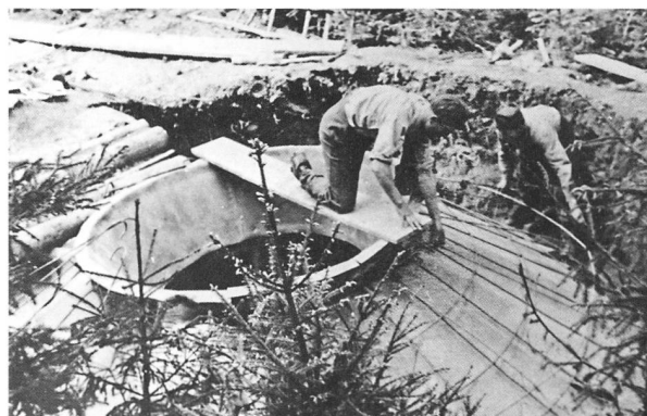
40 Armierter Beton verstärkt die Decke.
