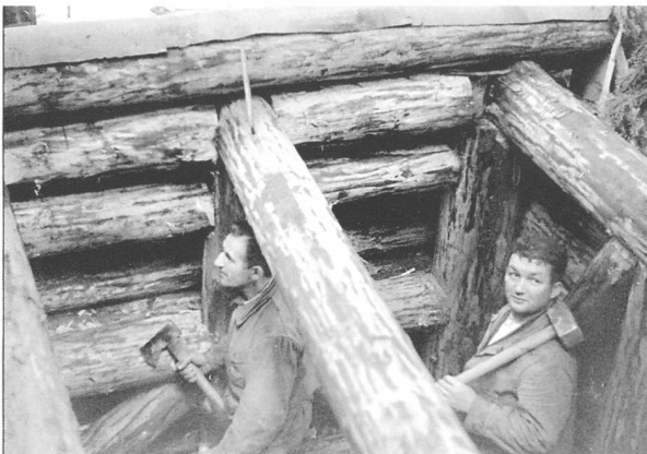
34 Bauteil eines Waffenstandes vor der Überdeckung.
