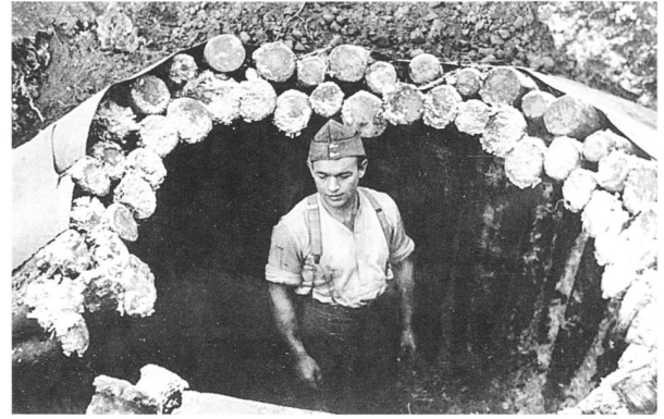
38 Schräg eingerammte Pfähle tragen die Decke.
