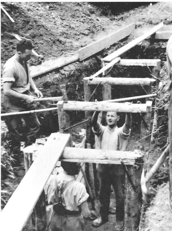
47 Stabilisierung der Wände; Beginn der Decke.
