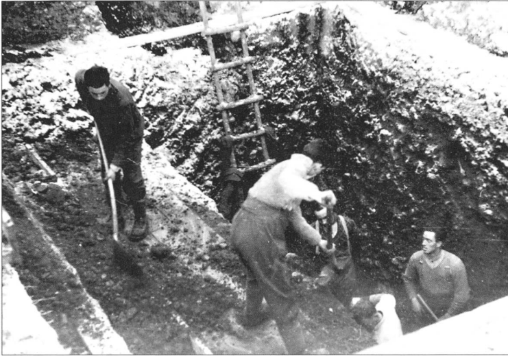
25 Pickel, Schaufel und eine selbst angefertigte Leiter sind die einzigen Hilfsmittel für den Aushub der Baugrube. Zu oft unterliessen die Soldaten das Abspriessen der Wände.
