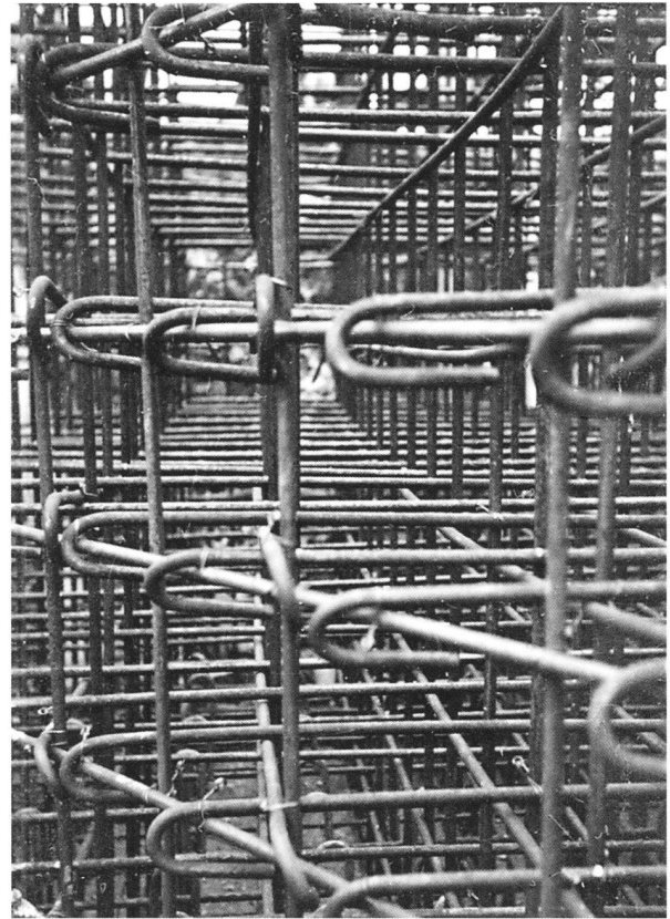
81 Die Eisenstangen können nicht einfach eingelegt werden. Sie sind überlegen verschlauft und erst noch mit Drähten fixiert.
