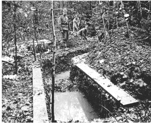
46 Heikler Bau: Das Wasser muss abgeleitet werden.
