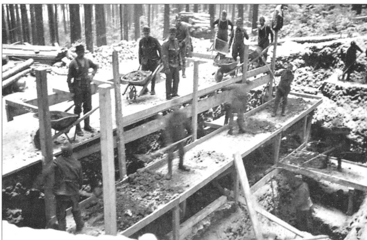
27 Die Bilder dieser Seite stammen von den Aushubarbeiten zu einem grossen Unterstand in der Sommerhalde: Die Grube ist jetzt schon so tief, dass drei Ebenen nötig sind, bis das Material in der Karrette landet.
