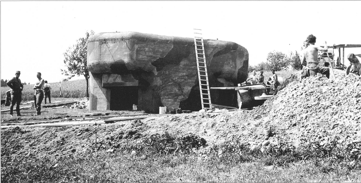
83 Der unterste der vier Bunker ist als letzter fertig geworden. Er wurde beim Bau der Badener Zivilschutzanlage abgebrochen. Die Leiter deutet an, dass oben noch Humus aufgetragen wird; es soll sich eine Grasdecke bilden.
