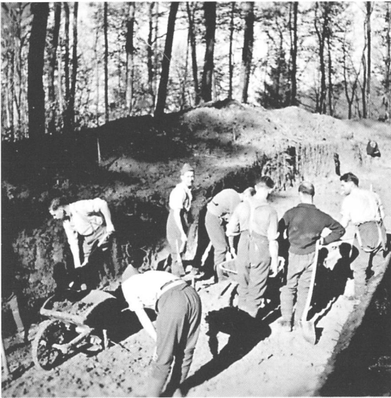
16 Unsere Gegend verdankt der Truppe viele Kilometer zweckmässig und solid verbesserte oder neu angelegte Waldwege. Hier sind die Soldaten mit der Vorbereitung des Trassees beschäftigt, indem sie einen Geländeeinschnitt zum Niveaueausgleich ausheben.
