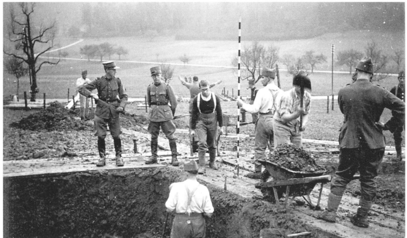
69 Der Aushub macht Fortschritte. Hinter den Leuten verläuft von rechts nach links durch die Bildmitte die Schaubigerstrasse; der Feldweg bei der Baumgruppe geht zum Segelhof hinauf.
