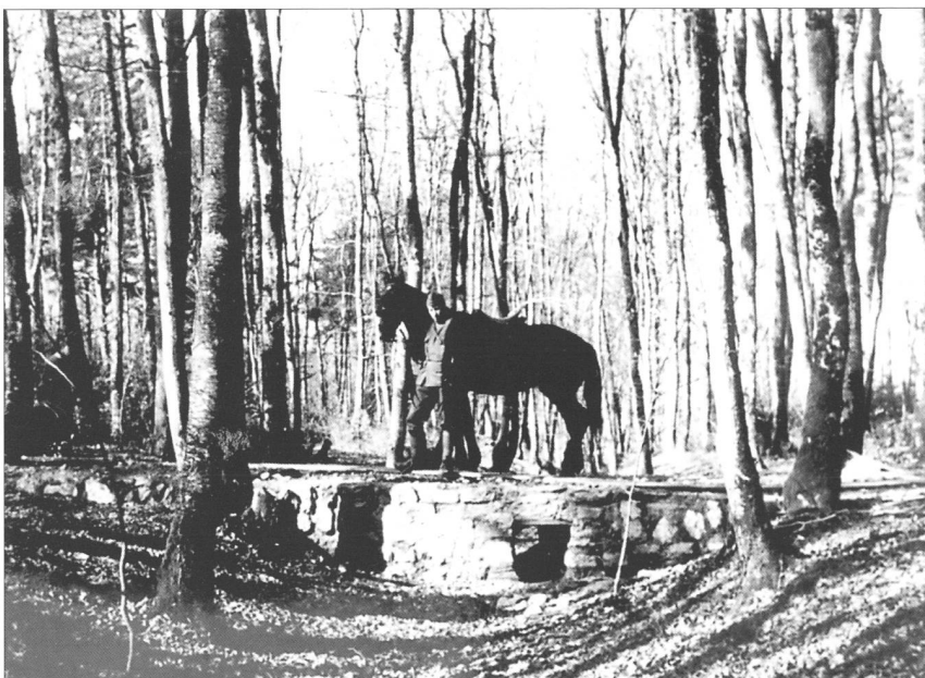
18 Beim Wegbau der Stabskompanie 44 am Schaubiger errichteten die Soldaten beim Queren eines alten Hohlweges einen kunstvollen Steindamm mit Wasserdurchlass. Er ist heute noch vorhanden, die Wegspur ist aber ganz überwachsen.
