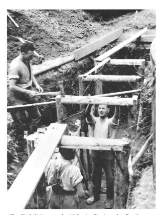
47 Stabilisierung der Wände; Beginn der Decke.
