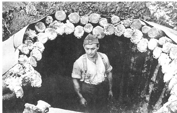
38 Schräg eingerammte Pfähle tragen die Decke.
