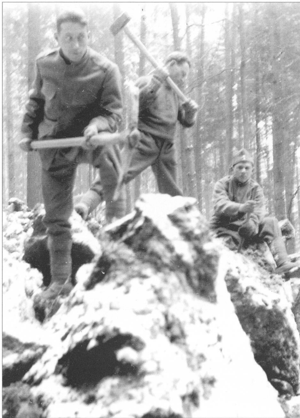
51 Deprimierende Arbeit: Eisenschlegel statt Pickel soll die Schollen lockern.
