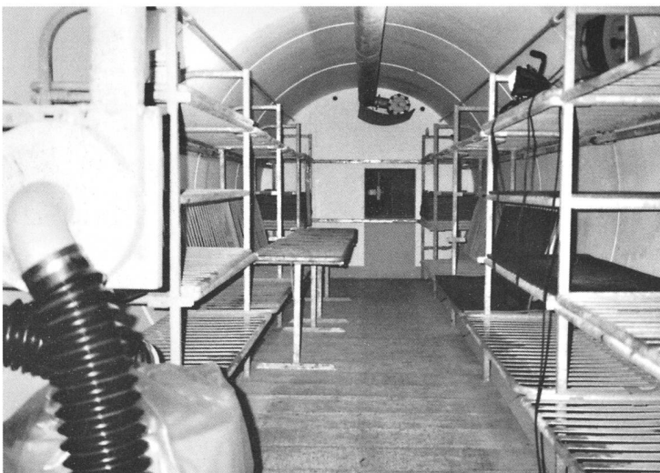
191 In der Stelli auf dem Bözberg gibt es noch einen ASU mit den selben Ausmassen wie bei der Birmenstorfer Anlage. Er ist noch voll ausgerüstet; die Bilder zeigen, wie unser Unterstand ausgesehen hat. Blick gegen den Notausgang. Foto 2012.
