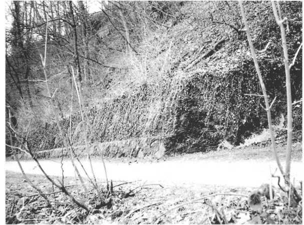
160 Die Mauer mit der westlichen Verankerung im Hang. Foto 1998.
