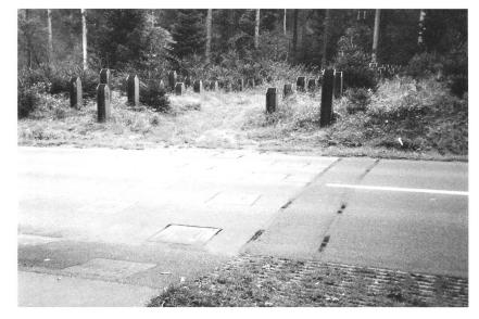
180 An der Fislisbacherstrasse im Waldstück zwischen Birmenstorf und der Hüenerstäg befand sich eine Panzersperre. Sie bestand aus massiven Stahlschienen; die Betonplatte in der Strasse war für die Aufnahme von Steckschienen vorbereitet. Foto 2005.
