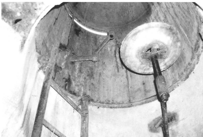
114 Sitz für den Beobachter unter der Kuppel; oben der Ausguck. Foto 2009.
