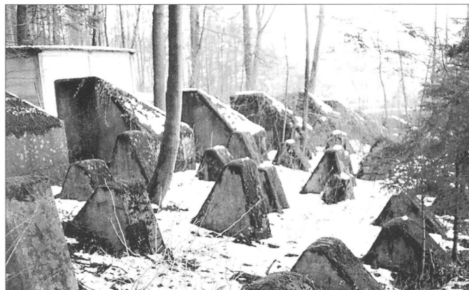
177 Baden Allmend. «Toblerone»-Höcker von 1940, links gesäumt mit einer Reihe von BBB- Blöcken von 1944. In der Betonbaracke hinten ist das Sperrmaterial für die Wegdurchlässe ein- gelagert. Foto 1996.
