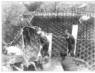
57 Links unten das Ende des Kännels. Die Soldaten müssen in den nächsten Stunden den Beton auf der ganzen Platte verteilen.
