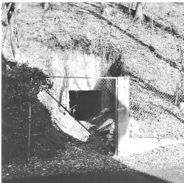
154 Der Eingang mit der Betonfassung und dem offenen Tor. Foto 1999.
