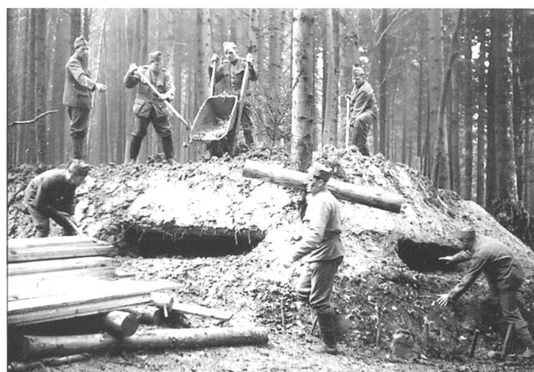
36 Fertig überdeckter Waffenstand mit 2 Scharten.
