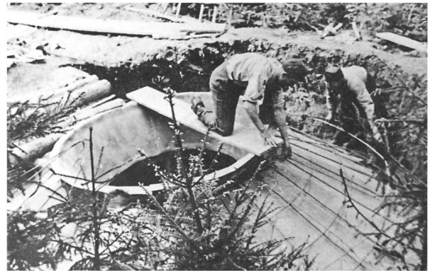
40 Armierter Beton verstärkt die Decke.
