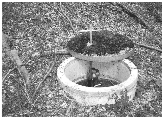
185 Dieser geöffnete Schacht birgt keine grossen Geheimnisse mehr; die Einrichtung ist entfernt.
