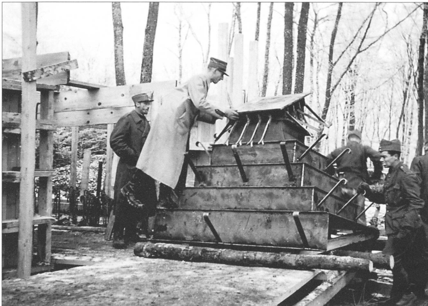
77 Die Schartenverkleidung aus Winkeleisen (unten) und die Abdeckung für die Frischluftöffnung (oben) sind eingetroffen. Sie müssen in die Schalung eingepasst und in den Beton eingegossen werden.
