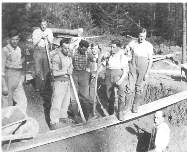
94 Irgendwo auf der Baldegg. Die Spielleute sind mit dem Aushub eines Unterstandes beschäftigt. Rechts auf dem Brett steht Josef Ambauen.
