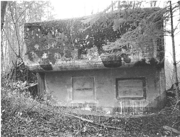
134 Dättwil, Rüteli. Geschützstand 1 für eine 8,4 cm-Kanone. Front mit Scharte für das Rohr und Scharte des Beobachters für den Direktschuss. Foto 2000.
