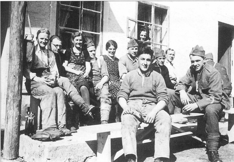
97 Die Soldaten des Bataillons 44, stationiert in Fislisbach und im Rütihof, bauten auch Stellungen zwischen dem Äschebach und dem Segelhof. Da genossen sie gern Arbeitspausen und oft auch Ofenwärme bei der «Marie vom Eschenbach».
