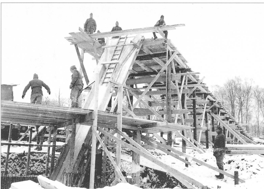
79 Damit die Gleise vom Materialplatz zur Baustelle horizontal verlegt werden konnten, war eine Brücke zu zimmern. Der Rutschkännel ist im Bau. Bald kann der Beton eingebracht werden.
