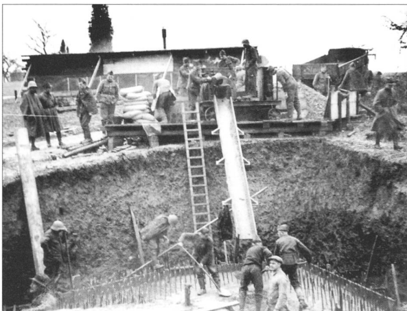
56 Über einen behelfsmässig aus Brettern gezimmerten Kännel rutscht der Beton in das Armierungsnetz der Grundplatte.
