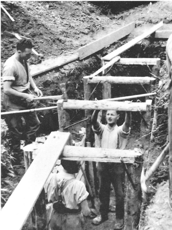
47 Stabilisierung der Wände; Beginn der Decke.
