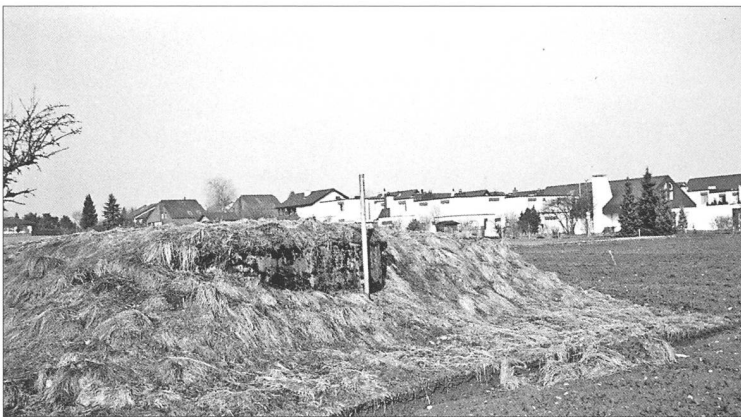
119 Von der Batterie 5 im Rütihof ist der betonierte Unterstand für den Schiessoffizier erhalten geblieben. Hier erhielt der Schiessoffizier vom Beobachter über eine Telefonleitung die Schiesswerte übermittelt; er wiederum gab sie per Telefon an die vier Geschützfürer weiter. Foto von 1996.
