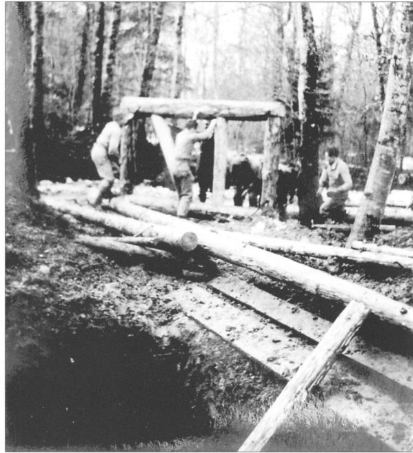
32 Zusammenbau der Rahmen am Abbindplatz.
