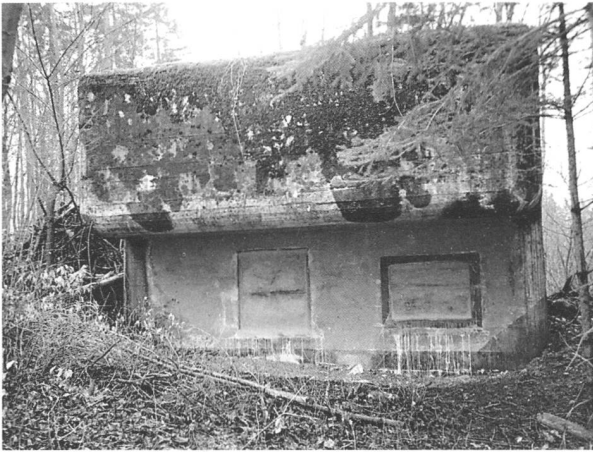
134 Dättwil, Rüteli. Geschützstand 1 für eine 8,4 cm-Kanone. Front mit Scharte für das Rohr und Scharte des Beobachters für den Direktschuss. Foto 2000.
