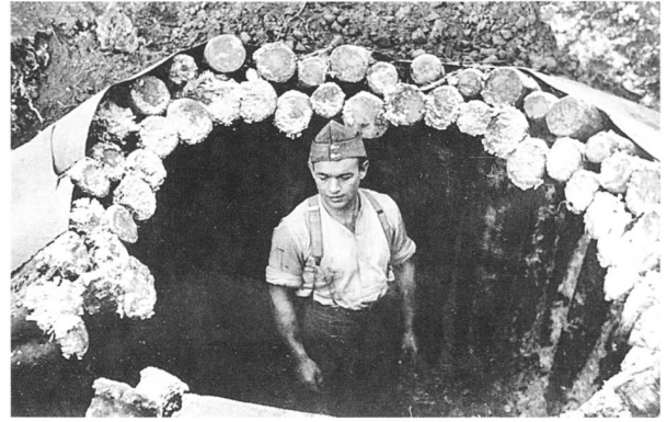
38 Schräg eingerammte Pfähle tragen die Decke.
