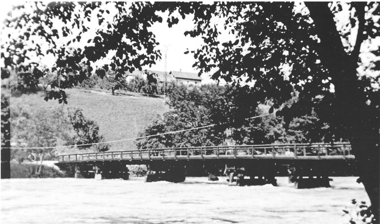
139 Die im Dezember und Januar 1939/40 gebaute Holzbrücke über die Reuss. Blick gegen die Birmenstorfer Seite. Der Fluss hat Hochwasser. Am Drahtseil kann eine Wagenfähre eingehängt werden, für die auch Zufahrten vorbereitet sind.
