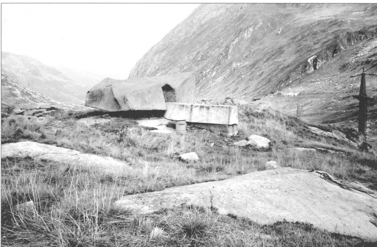
132 Als Steinblock getarntes Turmgeschütz. Zum Schiessen wird der Holzverschlag über dem Rohr weggelegt (San Carlo auf dem Gotthard). Foto 1998.
