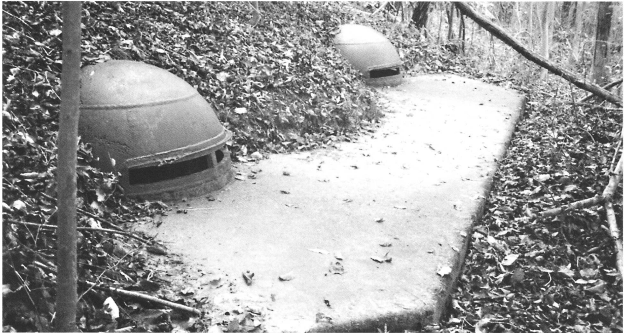
112 Sicht auf die beiden Beobachtungskuppeln. Durch einen Schlitz sieht der Beobachter über die Betonplatte hinweg nach Gebenstorf und auf das ganze Mündungsgebiet der Flüsse. Foto 2008.
