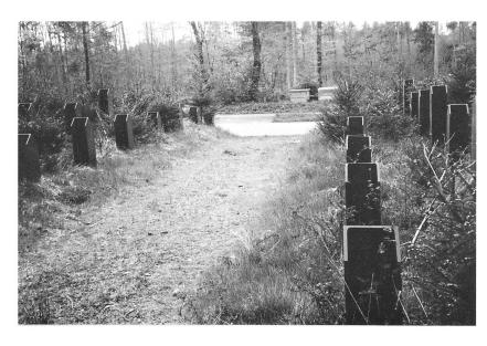
181 Das gleiche Hindernis: Vorn die Eisenschienen, hinten in der Strasse die Betonplatte und dahinter die Betonkisten mit den Steckelementen für die Strassensperre. Die Sperre wurde 2005 entfernt. Foto 2005.
