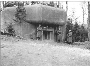
63 Das Bauwerk ist fertig. Bereits sind zur Tarnung links zwei Tännchen gepflanzt. Gut sichtbar ist die aus Winkeleisen gefertigte Scharteneinfassung.
