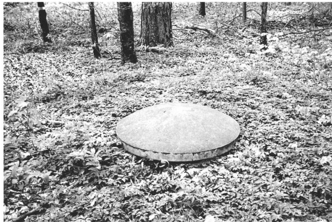
184 In einiger Entfernung befand sich jeweils der Zündschacht, aus dem elektrische Leitungen zu den einzelnen Schächten führten. Hier der zugehörige Schacht im Biremoos. Foto 2002.
