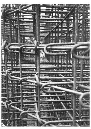
81 Die Eisenstangen können nicht einfach eingelegt werden. Sie sind überlegen verschlauft und erst noch mit Drähten fixiert.
