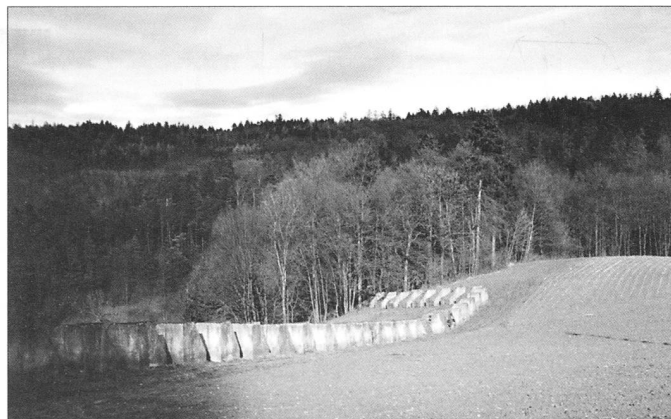
176 Teilstück Gebenstorf Steig, 44 Blöcke, zwei Wegdurchlässe. Abgebrochen. Foto 1987.
