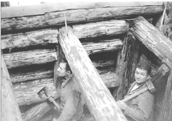
34 Bauteil eines Waffenstandes vor der Überdeckung.
