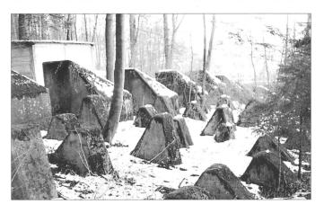
177 Baden Allmend. «Toblerone»-Höcker von 1940, links gesäumt mit einer Reihe von BBB-Blöcken von 1944. In der Betonbaracke hinten ist das Sperrmaterial für die Wegdurchlässe eingelagert. Foto 1996.
