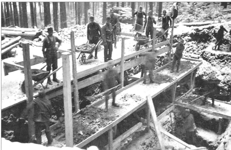
27 Die Bilder dieser Seite stammen von den Aushubarbeiten zu einem grossen Unterstand in der Sommerhalde: Die Grube ist jetzt schon so tief, dass drei Ebenen nötig sind, bis das Material in der Karrette landet.
