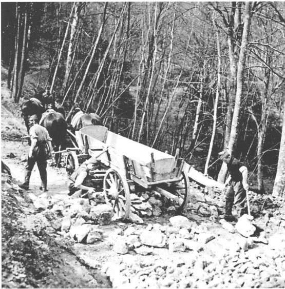
17 Mit requirierten Bennen werden aus Steinbrüchen Kalkbrocken herangeführt, mit dem Eisenschlegel zerkleinert und sorgfältig zum Unterbau versetzt. Die beiden Bilder stammen vom Wegbau unter dem Gebenstorfer Horn durch die Kompanie III/43.
