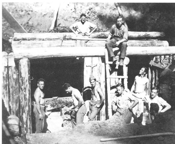
95 Der Bau ist weit fortgeschritten. Wie man sieht, verstehen sich die Musikanten auch auf die Zimmermannsarbeit.
