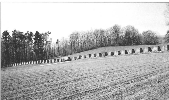
171 Teilstück Ämmert mit Wegdurchlass, 41 Blöcke. Foto 1987.
