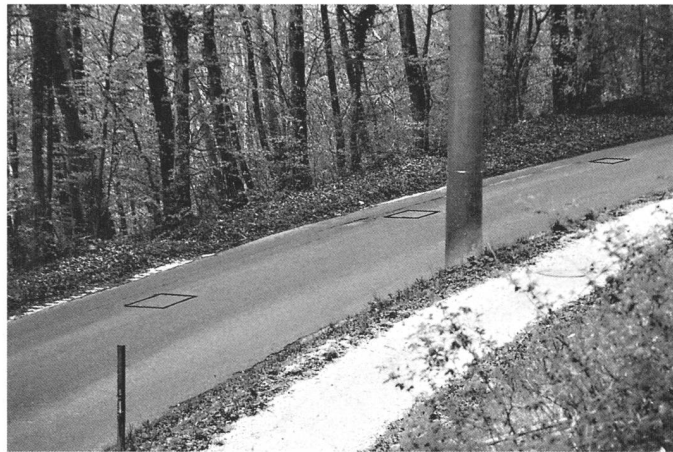
183 Wo die Mellingerstrasse zwischen Birnenstorf und Muntwil das Waldstück im Bodmersrai durchquert, gab es ein aus fünf Schächten bestehendes Sprengobjekt. Es ist beim Strassenausbau 2005 entfernt worden. Foto 2002.
