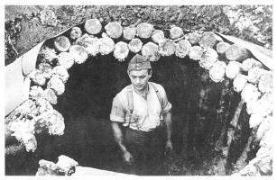
38 Schräg eingerammte Pfähle tragen die Decke.
