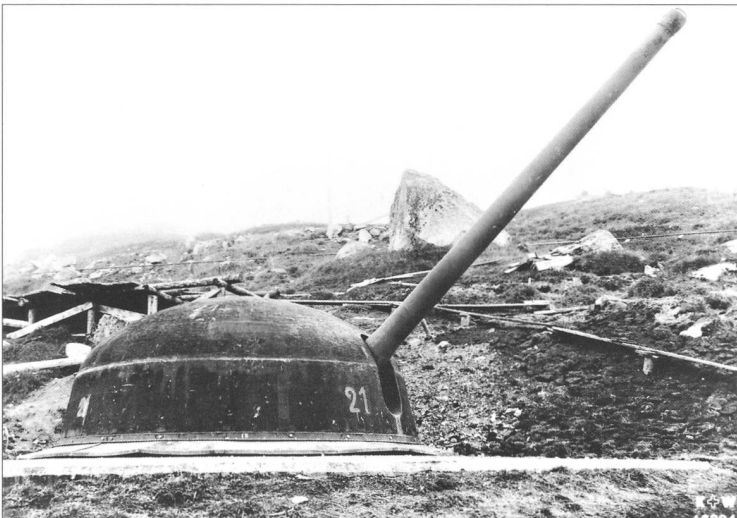
131 Die drehbare Stahlkuppel mit dem Geschützrohr, fotografiert nach der Montage vor der Tarnung (Fuchsegg an der Furka).
