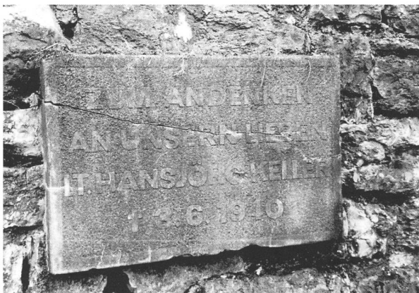
99 An der Wand des Geschützstandes 1 im Buacher Oberrohrdorf haben die Soldaten der Feldbatterie 69 eine Erinnerungstafel angebracht: «Zum Andenken an unseren lieben Lt. Hansjörg Keller + 3.6.1940».
