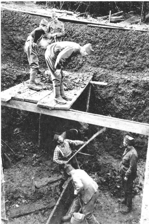
26 Je tiefer die Baugrube wurde, desto beschwerlicher wurde der Aushub. Auch wenn wir annehmen können, dass 75 Prozent der Innerschweizer Soldaten dem Bauern- oder Handwerkerstand angehörten, so war auch für sie die körperliche Belastung ausserordentlich; umso mehr galt das für andere Berufe.
