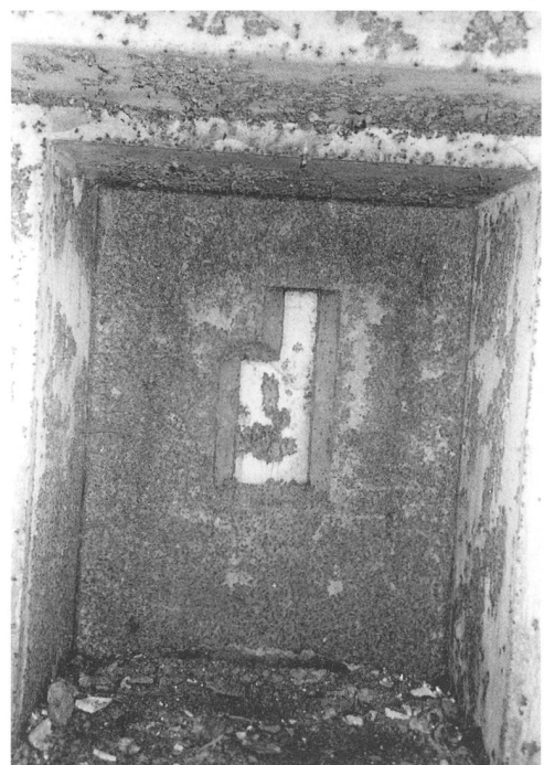
61 Industriell geschnittene Öffnung beim I.-Bunker Obere Kehlstrasse. Foto 2012.
