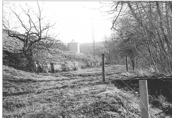
143 Vorn rechts ist das Widerlager der Brücke. Links erkennt man die Stützmauer zur Hangsicherung. Im Hintergrund die Gebäude der Lindmühle. Foto 1995.
