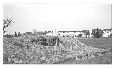
119 Von der Batterie 5 im Rütihof ist der betonierte Unterstand für den Schiessoffizier erhalten geblieben. Hier erhielt der Schiessoffizier vom Beobachter über eine Telefonleitung die Schiesswerte übermittelt; er wiederum gab sie per Telefon an die vier Geschützführer weiter. Foto von 1996.
