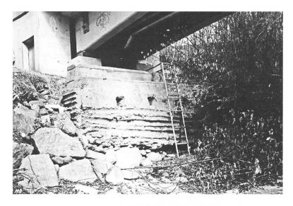
141 Als 1949 die Holzbrücke durch eine Betonbrücke ersetztwurde, konnte man die Widerlager weiter verwenden (auf der Birmenstorfer Seite erinnert die Jahrzahl «1939» an die Bauzeit). Die Fahrbahn der neuen Brücke liegt 2,5 m höher, um das Durchflussprofil zu verbessern. Foto 2006.
