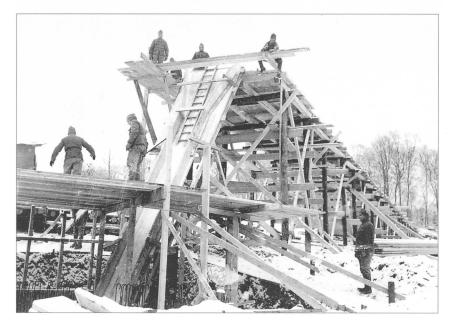
79 Damit die Gleise vom Materialplatz zur Baustelle horizontal verlegt werden konnten, war eine Brücke zu zimmern. Der Rutschkännel ist im Bau. Bald kann der Beton eingebracht werden.
