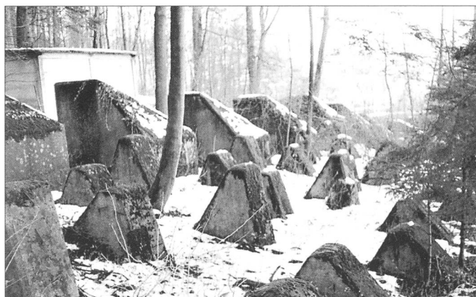
177 Baden Allmend. «Toblerone»-Höcker von 1940, links gesäumt mit einer Reihe von BBB- Blöcken von 1944. In der Betonbaracke hinten ist das Sperrmaterial für die Wegdurchlässe ein- gelagert. Foto 1996.
