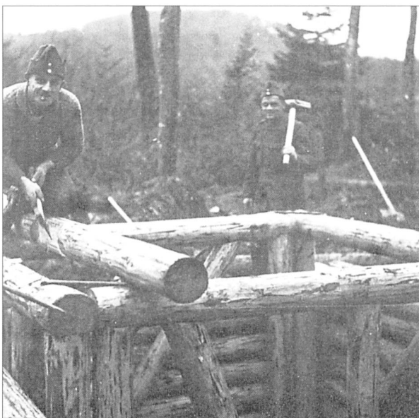
35 Waffenstand. Der Deckenaufbau beginnt.
