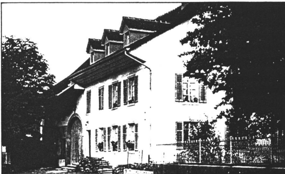
Im Wohnteil des Hauses Kirchstrasse 3 stecken noch Elemente des Königsfelder Gerichtshauses (1680 - 1792).
