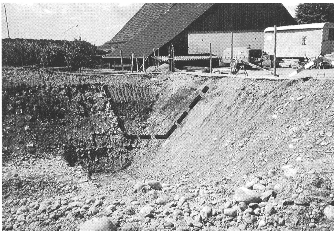
Bild 5. Baugrube der Mehrzweckhalle. Die gestrichelte Linie umreisst die Aufschüttung der früheren Bachrinne. Bild von 1987.
