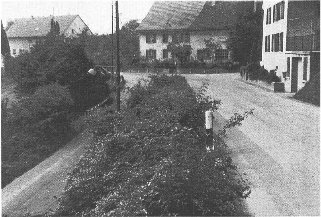
Bild 6. Heikle Stelle seit alter Zeit war die Verzweigung Badenerstrasse/ Mellingerstrasse in der Fell, hier auf einem Bild von 1968, Blick dorf- einwärts. Seit den 1820er Jahren war die Mellingerstrasse hier durch eine massive Stützmauer befestigt. Vorher war bei nassem Wetter die ganze Ver- zweigung häufig abgerutscht.
