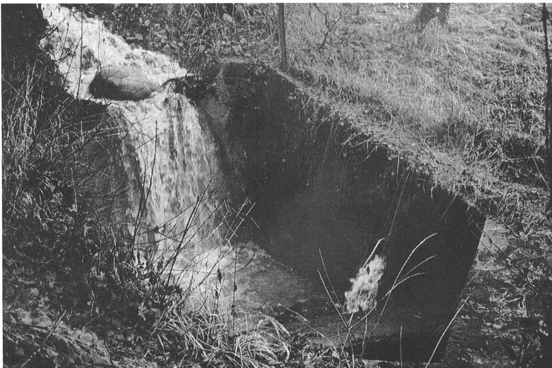
Bild 8. Am Wildbach. Von links oben strömt das Wasser der Quellen 1 und 2, hier mit einer Wassermenge von etwa 300 Litern pro Minute. Rechts unten sprudelt die Quelle 3 direkt in den Sammler. Bild von 1979.
