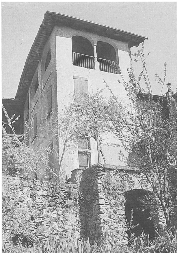
Fig. 2 - Muzzano. Esterno della casa patrizia Andreoli-Staffieri prima del restauro generale del 1972.
