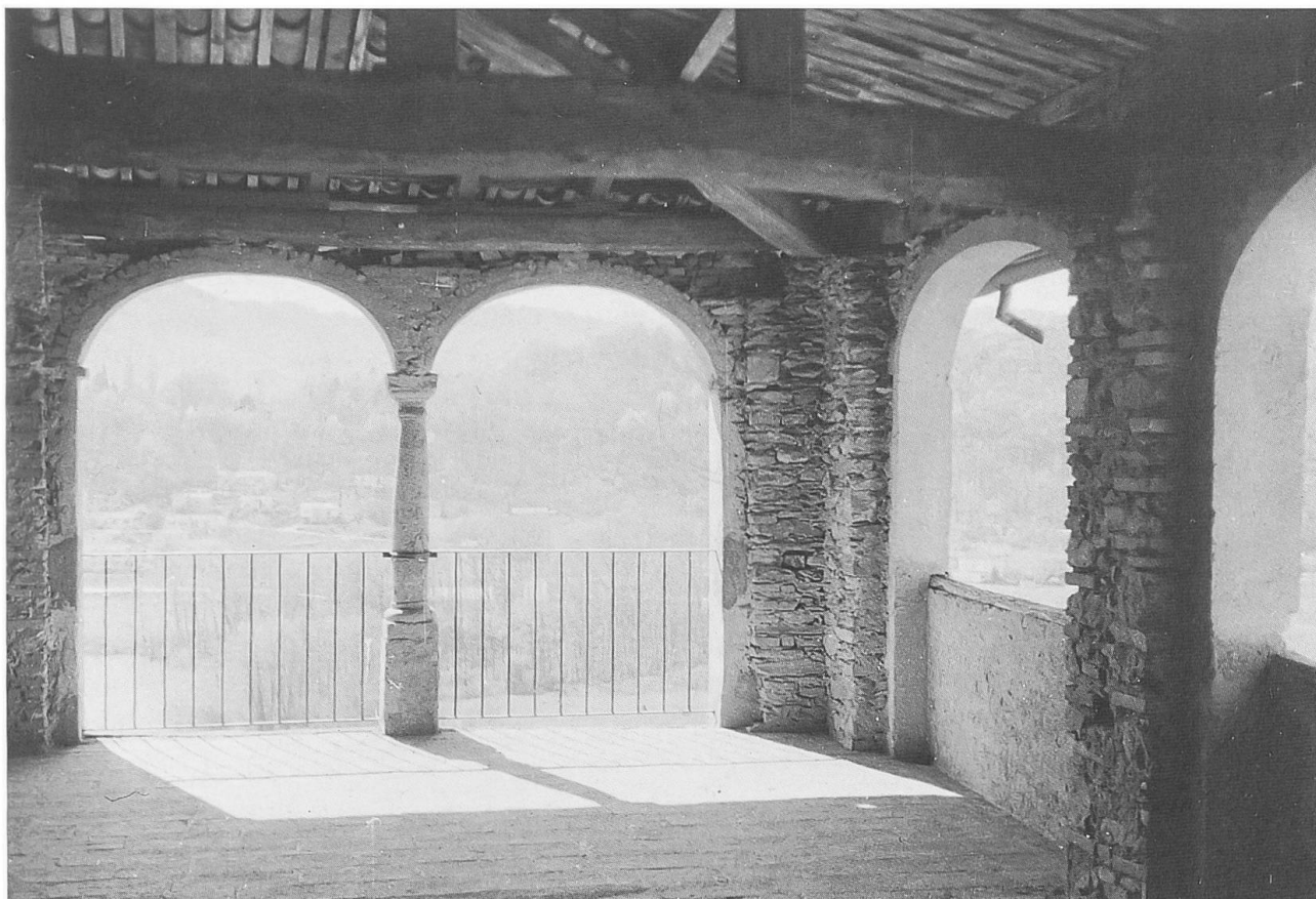
Fig. 3 - Muzzano. Panorama dall'interno del locale superiore a loggia della casa patrizia Andreoli-Staffieri verso meridione, prima del restauro.
