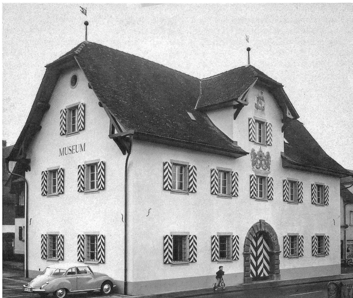
11 Das ehemalige Salzmagazin an der Stansstaderstrasse in Stans wird heute für museale Zwecke genutzt.
