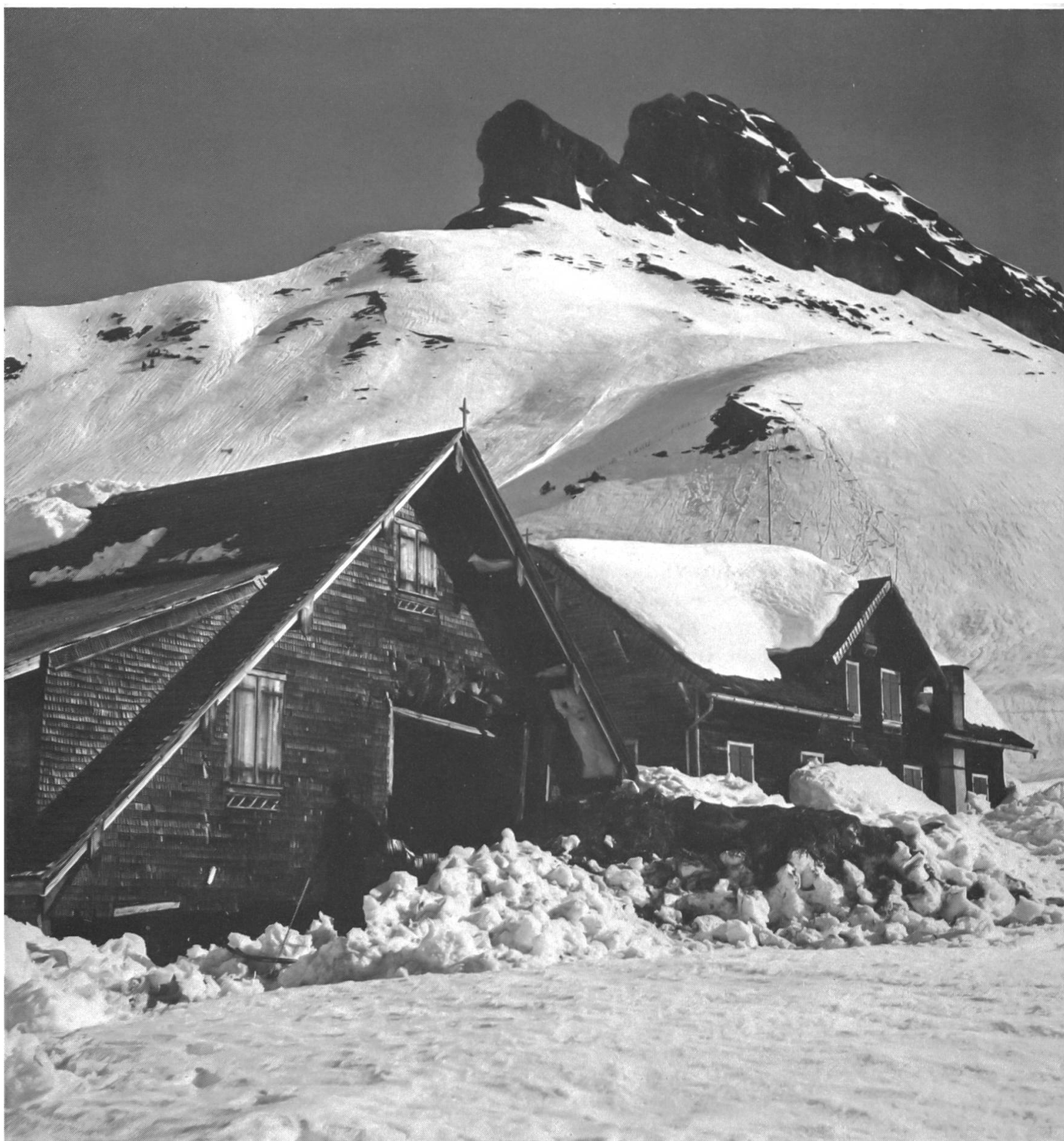
60 Am selben Tag, an dem Lawinen auf Singgäu und Lutersee verheerende Schäden angerichtet haben, wurden auf Bannalp die Gebäude im Ober Urner-Stafel durch eine Lawine zerstört. Das Bild vom 15. März 1945 zeigt die Schäden im Unter Urner-Stafel. Die Lawine hat zwei Wände eingedrückt, das Gebäude konnte aber wieder in Stand gestellt werden. Im Hintergrund die Pension Urner Stafel, die Ende Februar 1960 vollständig abgebrannt ist.
