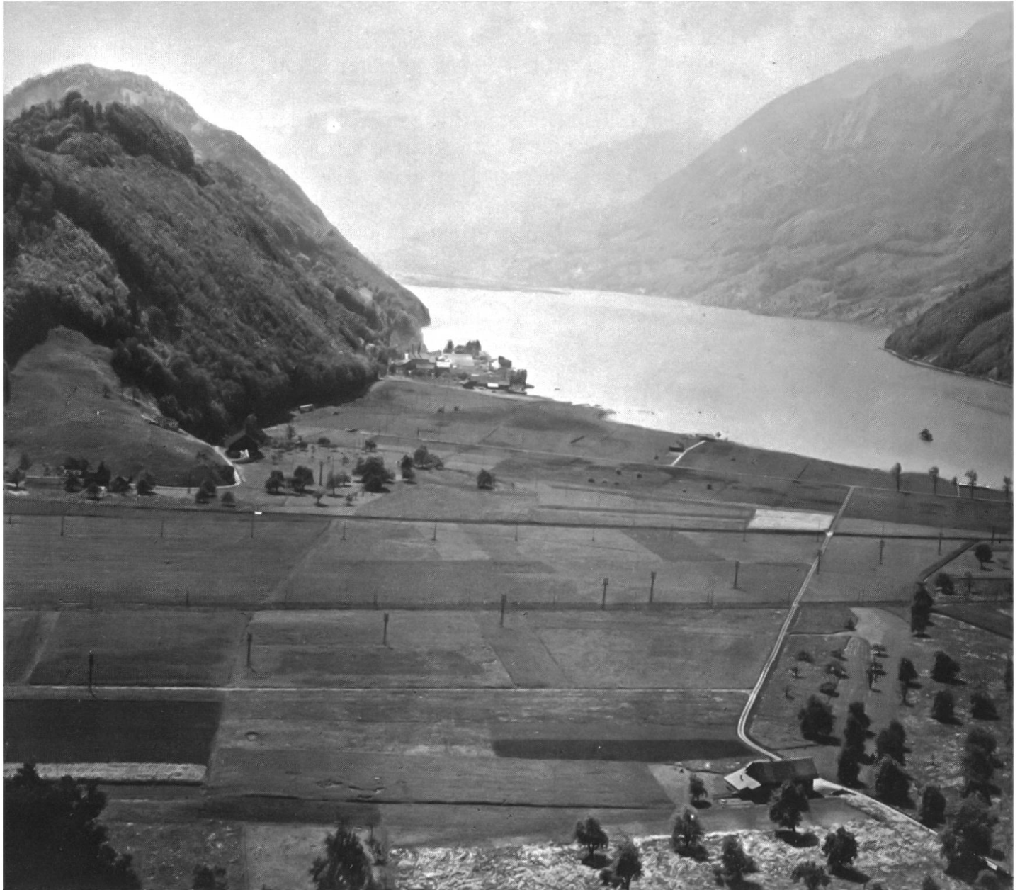
20 Blick von der untern Stöckmatt auf die Melioration Galgen- und Stansstadterried im Frühjahr 1946. Rechts der Alpnachersee mit Lopper; links das Gotthardli, die Murmatt und der Allweg; in der Mitte der Rotzberg, davor das Meliorationsgebiet. Das Land ist vollständig trockengelegt und ausplanert. Drei- bis viermaliger Umbruch haben jegliche Bodenunebenheit verschwinden lassen. Dieses Gebiet ist heute vom selben Standpunkt aus kaum mehr wiederzuerkennen. Es ist von der Autobahn zerschnitten und weitgehend überbaut. Dies ist ein typisches Beispiel für das Schicksal der landwirtschaftlichen Prioritätsgebiete in den Talböden Nidwaldens. Von der Mündung des Kanals (rechts im Bild) in den Alpnachersee bis zur Achereggbrücke lag das Garnhänkried, das zu Beginn des zweiten Weltkrieges aufgeschüttet und trockengelegt wurde. Diese sogenannte Kolmation Stansstad (vgl. Abbildung 23) wurde mit dem Anteil Nidwaldens am Gewinn auf dem Goldbestand der Nationalbank finanziert. Am 27. September 1936 war nämlich der Schweizerfranken um 30% abgewertet worden. Dies hatte zu einem Mehrwert des Goldbestandes in neuer Währung geführt. Von diesem Gewinn wurden 150 Millionen Franken an die Kantone im Verhältnis ihrer Wohnbevölkerung verteilt, Nidwalden bezog 555 344 Franken.
