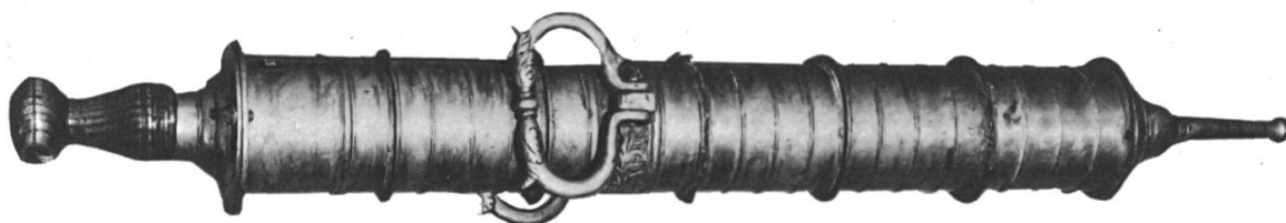
8. Handfeuerspritze aus Messing, mit hölzernem Kolben. Der Druckstrahl wurde erzielt durch Eintauchen der Spritzenspitze in einen mit Wasser gefüllten Zuber, Einsaugen des Wassers durch Anheben des Kolbens und rasches Hineinstossen des Kolbens. — Die Spritze aus dem Jahre 1615 war im bernischen Schloss Gerzensee in Gebrauch. Schweiz. Feuerwehrmuseum Basel.
