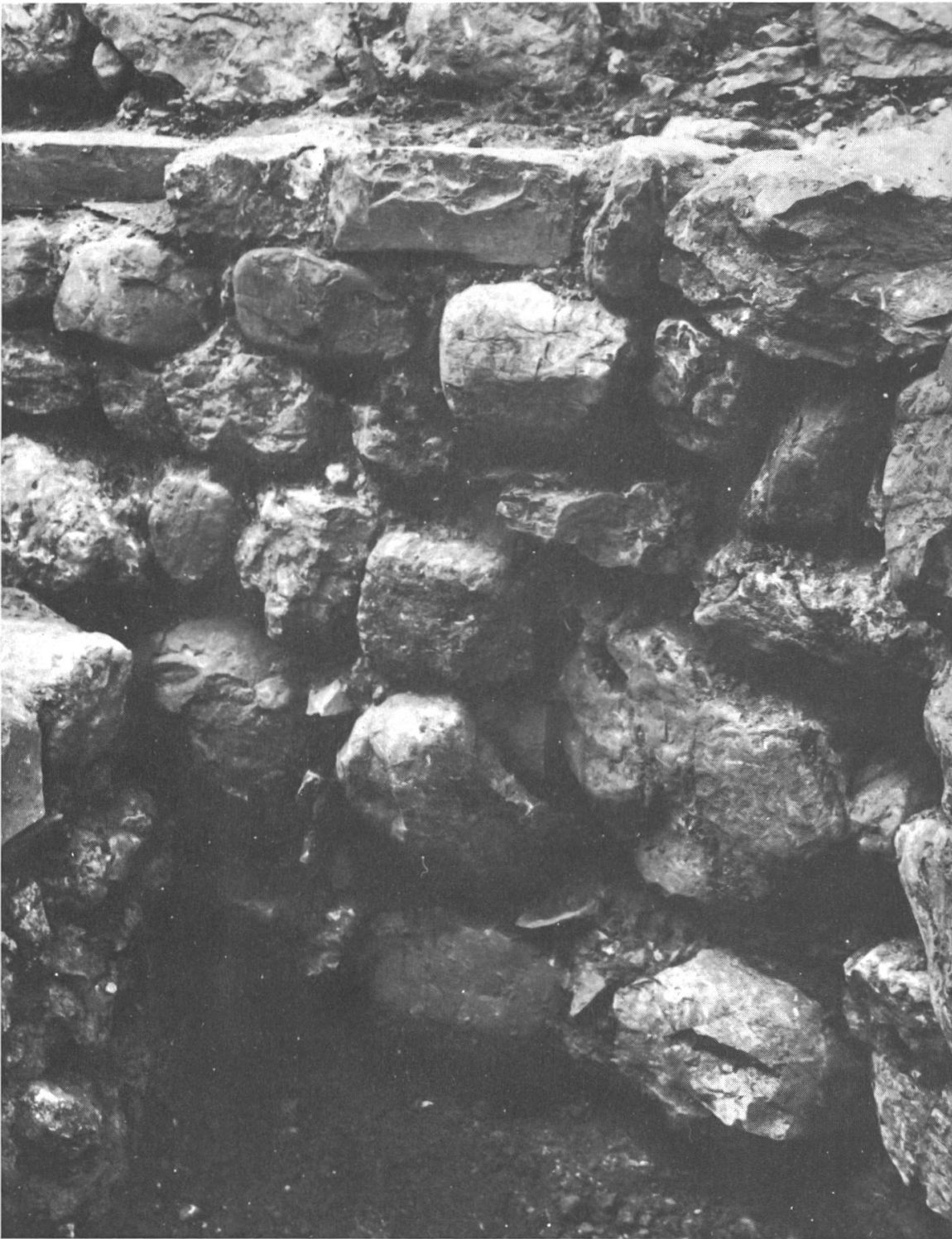
65. Maueransicht. Ansatz der romanischen Apsis an der südöstlichen Schultermauer.
