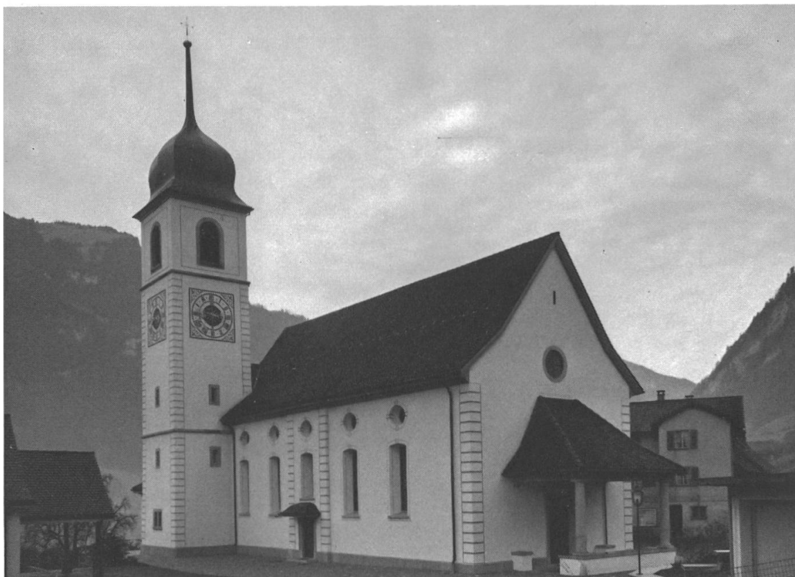
21. Gleiche Ansicht nach der Restaurierung
