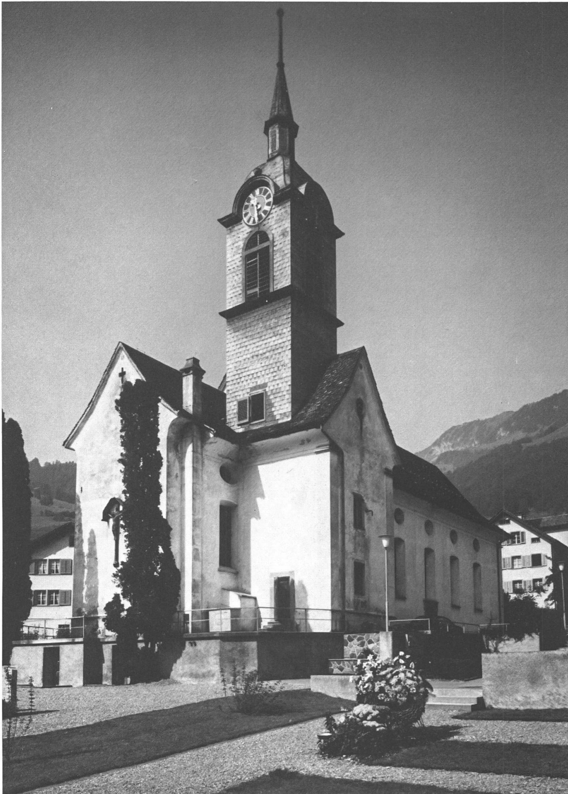
22. Ansicht von Osten vor der Restaurierung
