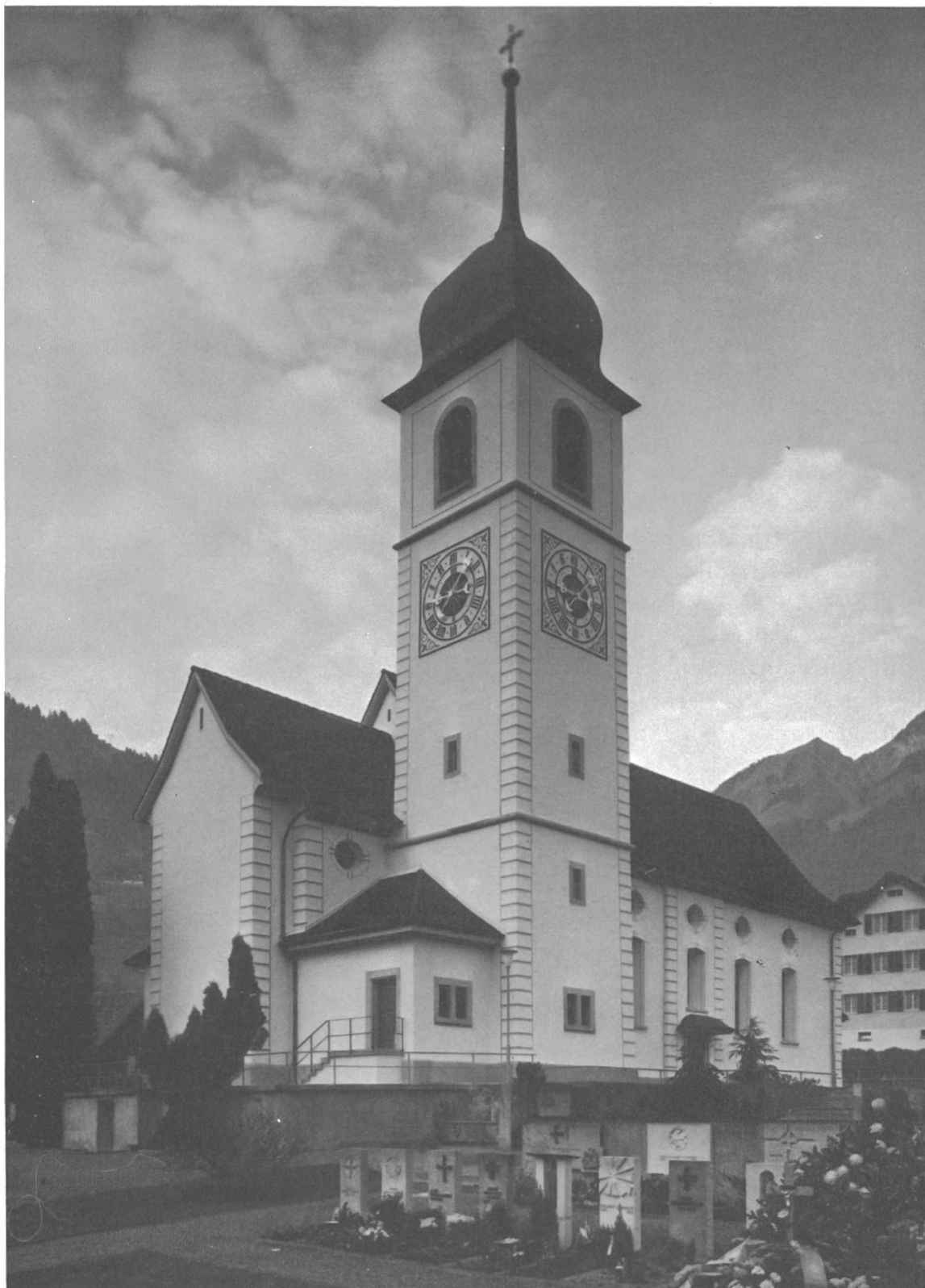
23. Gleiche Ansicht nach der Restaurierung
