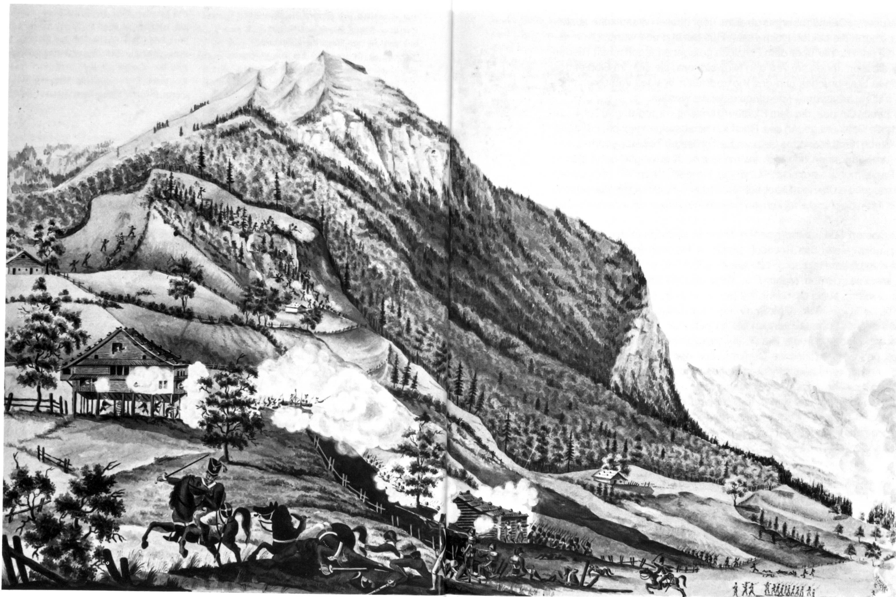
Der Angriff der Franzosen am 9. September 1798 auf die Bieli-Schanze in Ennetmoos. Rekonstruktion von Hptm. Louis-Victor von Deschwanden (1795-1878), der schon mit 12 Jahren als Kadett in Spanien diente. Historisches Museum Stans.
