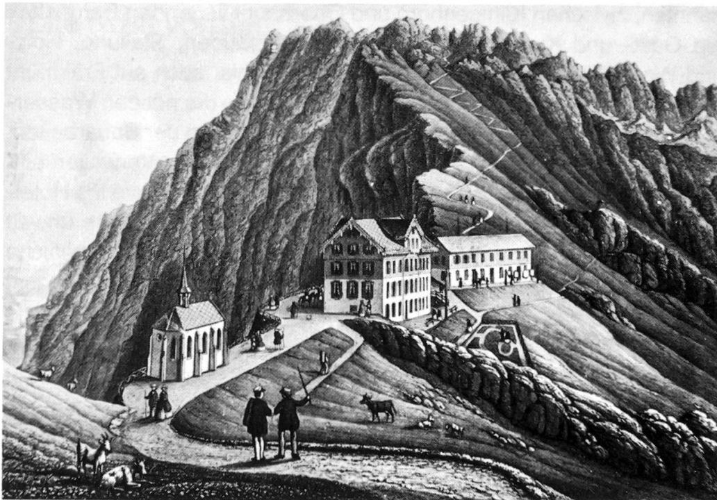
Hotel «Klimsenhorn» mit Kapelle. Stahlstich ca. 1865
