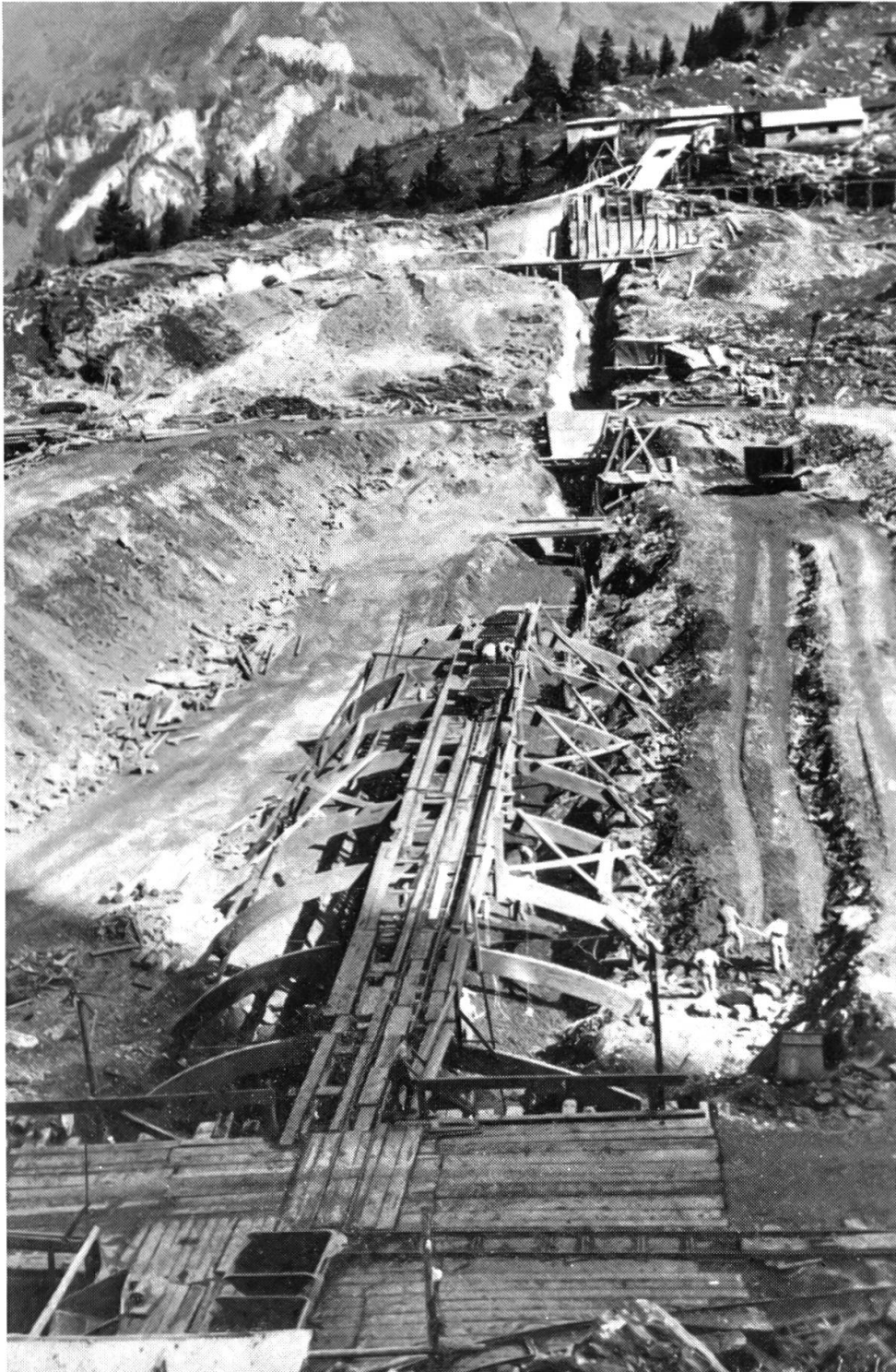
Übersicht über die Baustelle im Bereich des Staudammes. Unterhalb der Bildmitte ist die Holzspriessung zu erkennen, auf der einige Rollwagen stehen, die den Lehm in den vorbereiteten Graben kippen.
