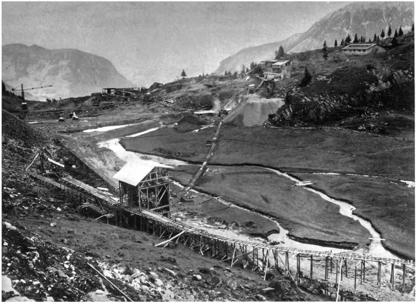
Rollbahn für den Lehmtransport zum Staudamm. In der Bildmitte die Mischanlage, wo der Lehm mit Kies durchsetzt wurde (siehe S. 218).
