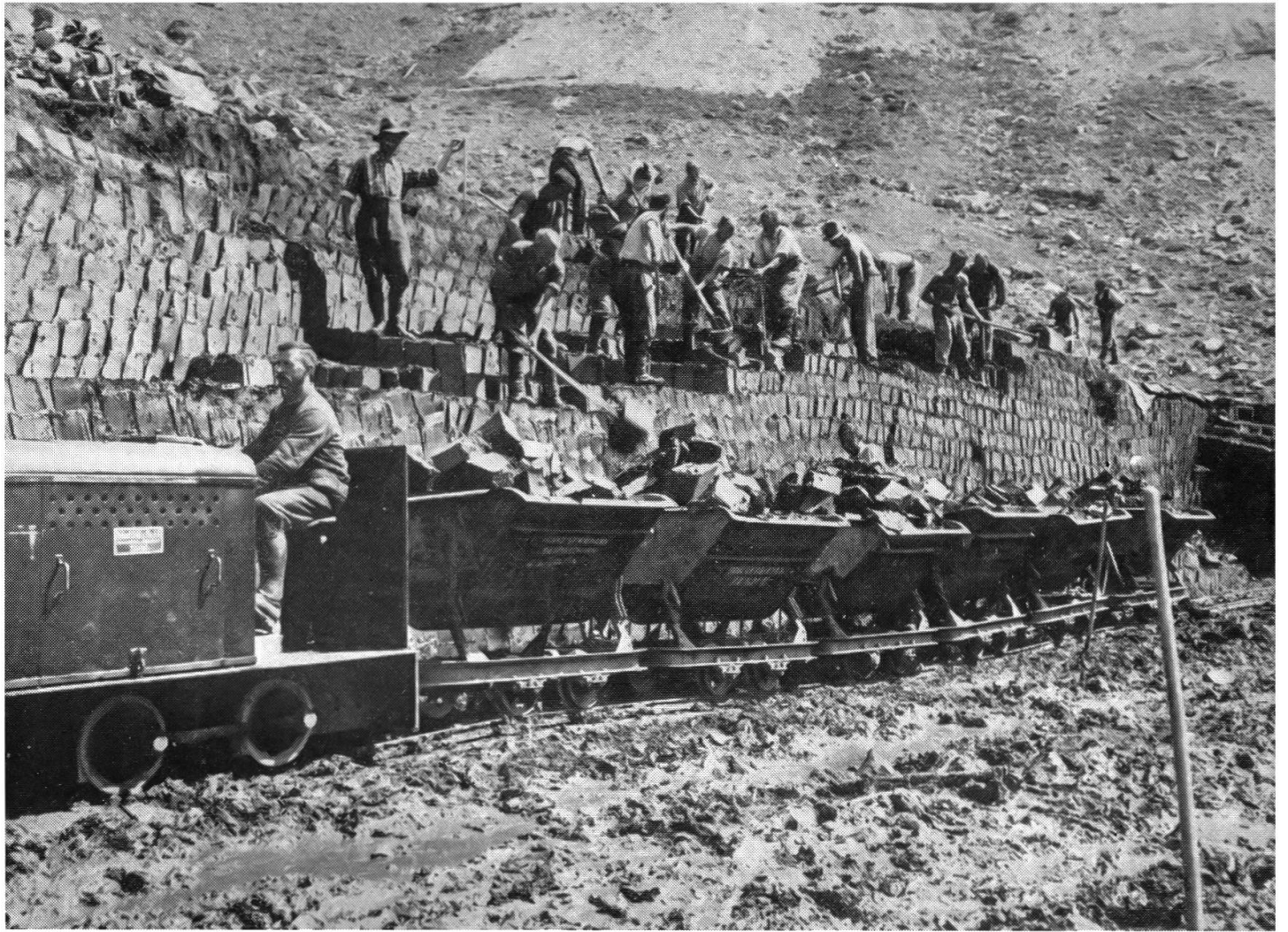
Lehmgewinnung im hintern Teil des zukünftigen Staubeckens. Der Lehm wird durch eine Drehgabel in Würfel geschnitten und auf Rollwagen zum Damm transportiert (siehe S. 218).
