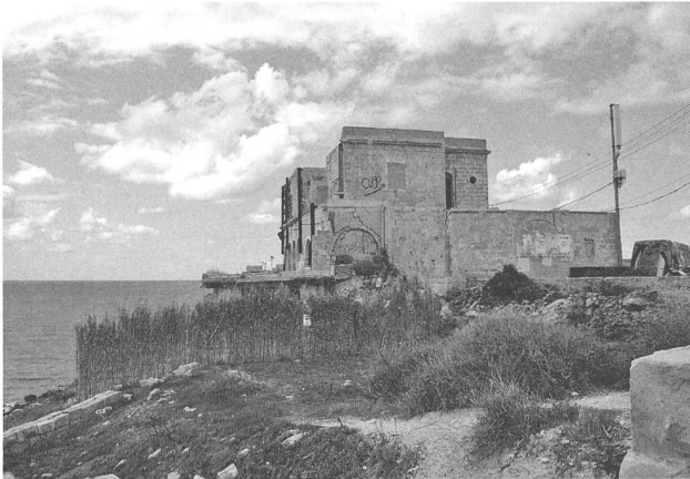
Abb. 6: Ehemaliges an der Abruchkante stehendes Hotel (Foto: Elisabeth Bäschlin)
