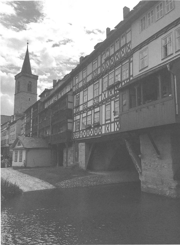
Abb: 2: Erfurt – Krämerbrücke über die Gera (Foto: Matthias Giger)
