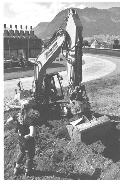
Abb.2: Entnahme von Bodenproben zur Untersuchung des Antimonseintrag beim Schiessplatz Ennetbürgen (2020).
