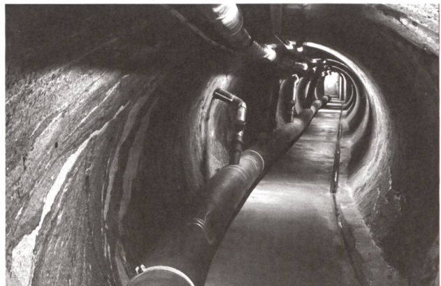
Abb. 5: Im Stollen von Laufenburg /CH. Erläuterungen im Text.
