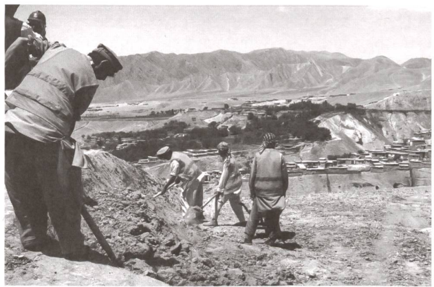
Abb 1: Strassenbau ohne Maschine zur Einkommensgenerierung (Foto: Xenia Kirchofer)
