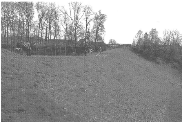
Abb. 1: Grabenbach unterhalb von Tägertschi: Hochwasserschutzdamm der Gemeinde Münsingen
