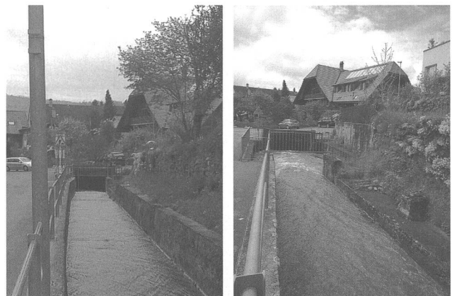
Abb. 4: Einlauf des Grabenbaches in den unterirdischen Stollen oberhalb des Dorfzentrums von Münsingen, links am Tage der Exkursion (25. April 2015), normale Wasserführung, rechts nach einer Regenperiode am 4. Mai 2015 (Bild: Monika Wälti).
