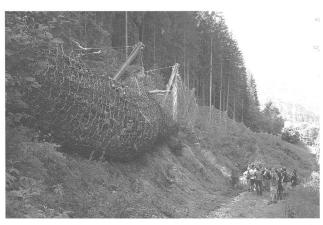
Abb. Tirol 1: Stahlseilsicherung im Paznauntal
