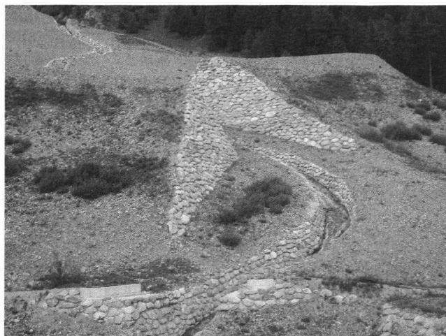
Abb. 4: Schutzverbauungen oberhalb Pontresina
