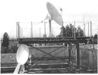
Die Empfangsantennen (links: für den geostationären Meteosat-Satelliten; oben: für die polarumlaufenden NOAA-Satelliten) der Gruppe für Fernerkundung im operationellen Betrieb.
