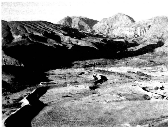
Abb. 1: Ablenkdamme im Wadi (Bild U. Brunner)
