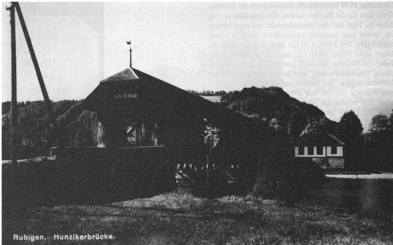
Abb. 3: Die Hunzikerbrücke kam 1836 in Betrieb, wurde 1972 durch eine Betonbrücke ersetzt, danach zerlegt und etwas weiter aareabwärts im Auguet wieder aufgebaut und 1974 für Fussgänger wieder in Betrieb genommen. Das Bild stammt aus dem Jahre 1920 (Postkarte, Sammlung Hans Habegger, Rubigen).
