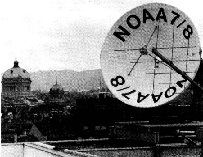
Auf dem Dach des Instituts für Exakte Wissenschaften befindet sich eine Parabolantenne von 3 m Durchmesser. Sie ist dreh- und schwenkbar montiert und dient zum Empfang von digital codierten Signalen von Satelliten der NOAA-Serie
