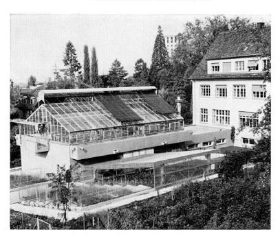
Ansicht von Osten. In der Bildmitte erkennt man den neuen Anbau mit Gewächshaus, rechts den Altbau. Im Vordergrund und in der Mitte links sind die in den Boden eingelassenen, treppenartig angeordneten Grundwasserbecken; vorn in der Mitte befindet sich das durchsichtige Schiebedach, das sich bei Regenbeginn automatisch nach links über die 6 oberen Grundwasserbecken schiebt.
