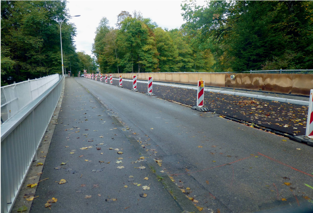
Während Monaten wird die Heimiswilbrücke totalsaniert (Foto: Viktor Kälin)
