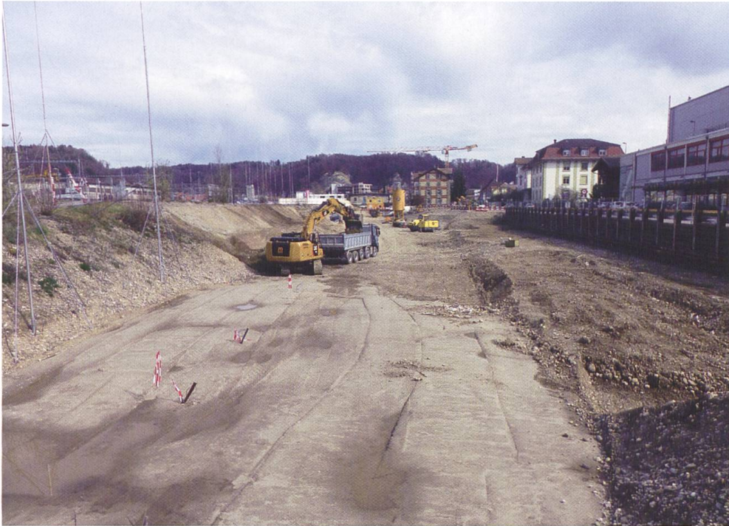
Die Baugrube auf dem ehemaligen Aebi-Areal ist imposant (Foto: Viktor Kälin)
