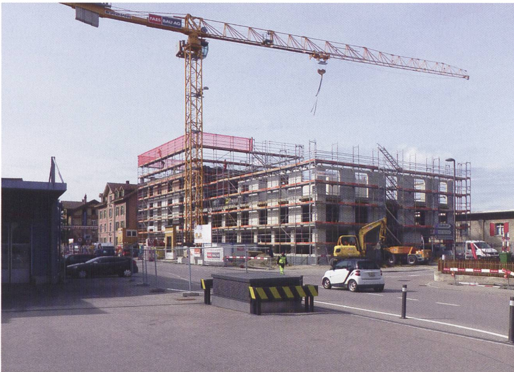
Das Bautempo beim Ärztehaus an der Lyssachstrasse ist hoch (Foto: Viktor Kälin)
