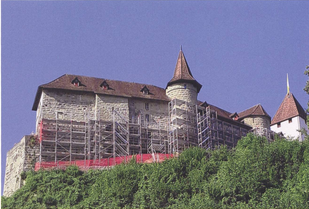
Die Nordfassade des Schlosses wird eingerüstet; die geplanten Restaurierungsarbeiten können beginnen (Foto: Hans Aeschlimann)
