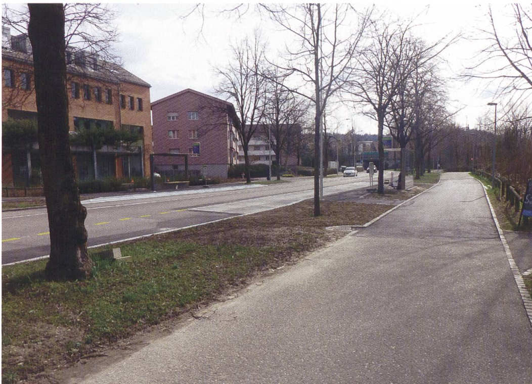
Die zwei Bushaltestellen beim Tiergarten wurden behindertengerecht umgebaut (Foto: Viktor Kälin)
