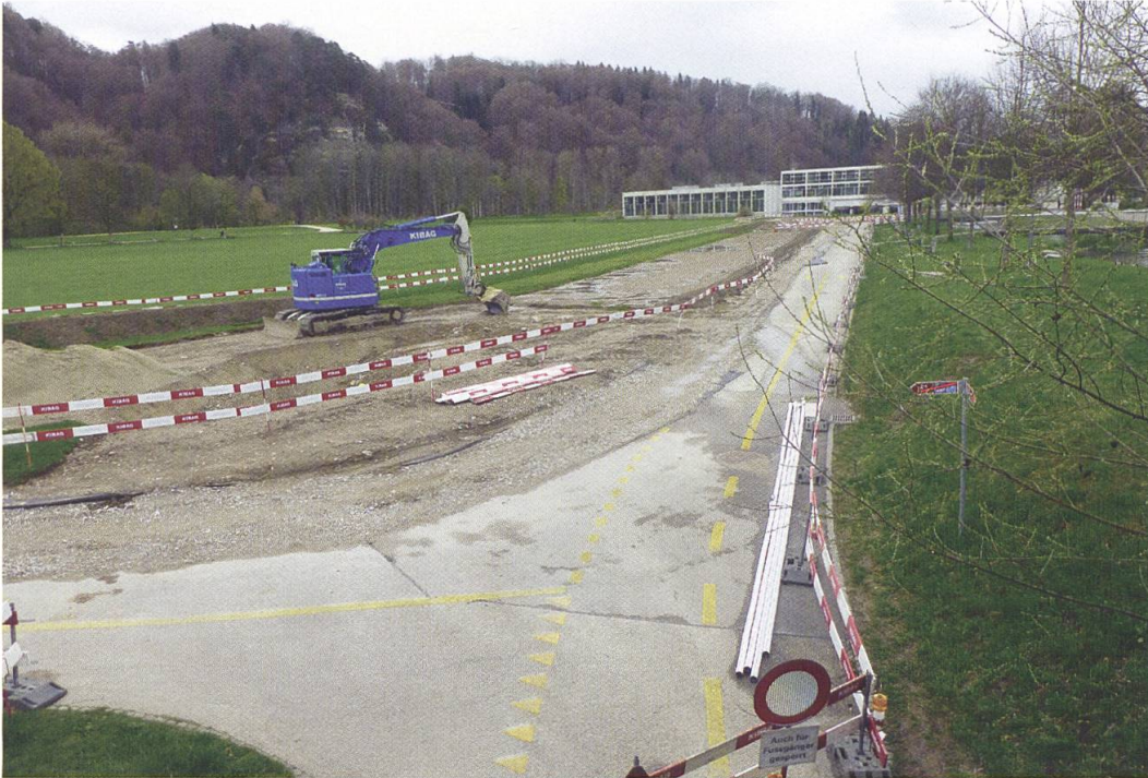
Während längerer Zeit wird an den Fernwärmeleitungen und an der HD-Gasleitung gebaut, so auch auf der Schützematte (Foto: Viktor Kälin)
