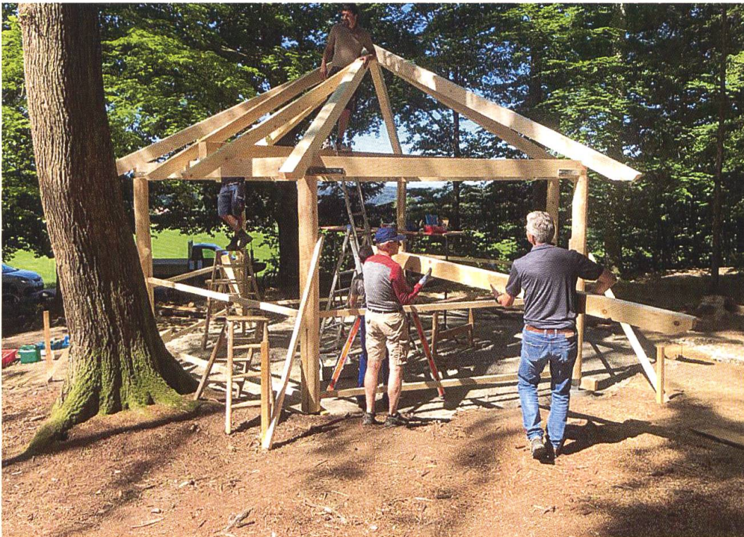
11. Juni 2022: Die Dachkonstruktion entsteht
