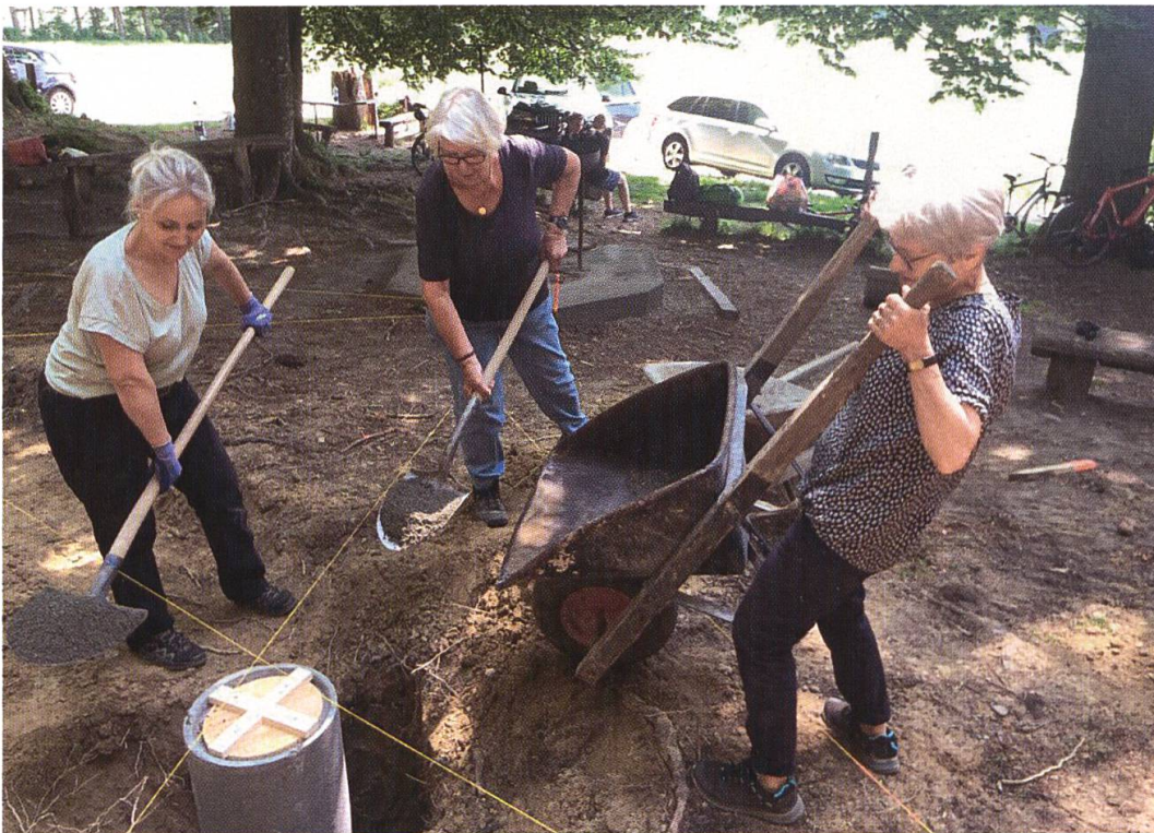
21. Mai 2022: Die Pfostenfundamente werden gesetzt
