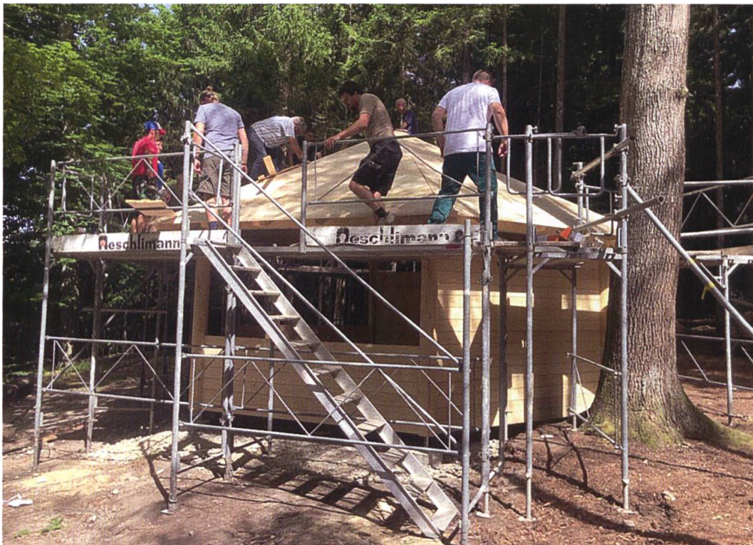
18. Juni 2022: Die Dachdecker
