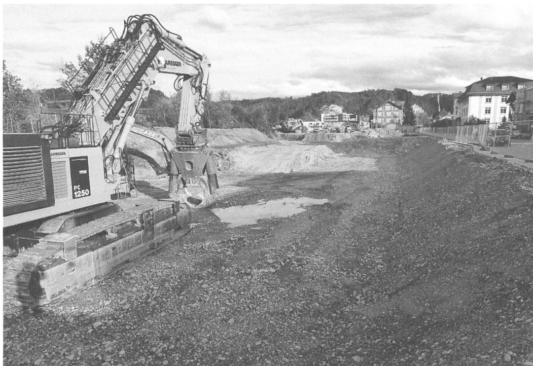
Wo einst die «stolze» Landmaschinenfabrik Aebi ihre Maschinen produzierte, ist nur noch eine imposante Baugrube übrig geblieben (Foto: Viktor Kälin)
