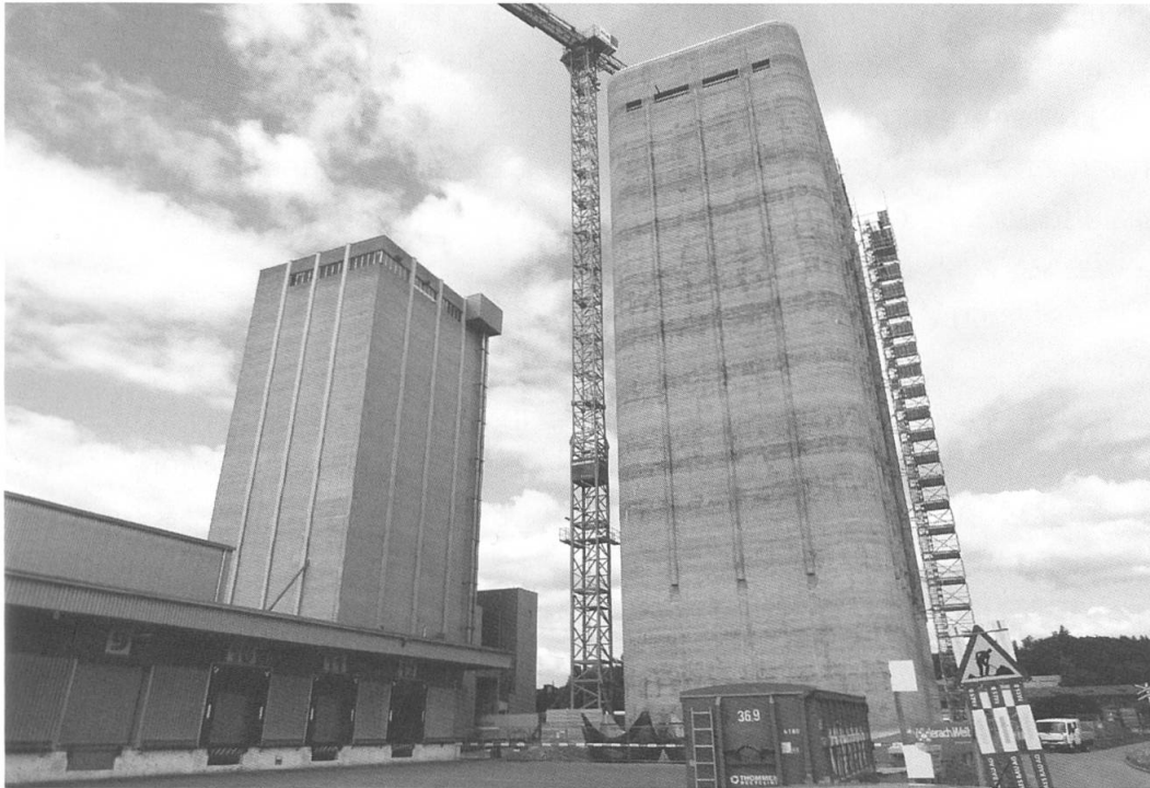
Direkt neben dem bestehenden Mischfutterwerk baut die KUNZ KUNATH AG einen neuen Siloturm (Gleitschalensystem) zur Lagerung von Getreide und Soja (Foto: Viktor Kälin)
