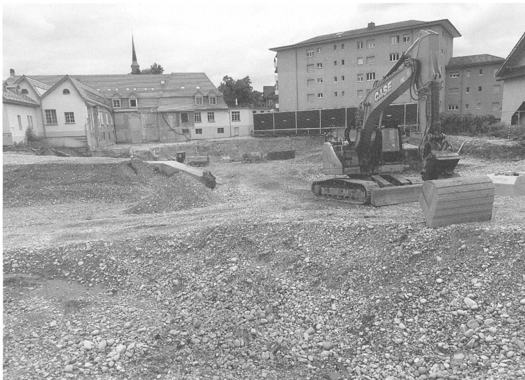
Bucherareal: wo momentan eine riesige Baugrube klafft, soll eine grosse Wohnsiedlung entstehen (Foto: Viktor Kälin)
