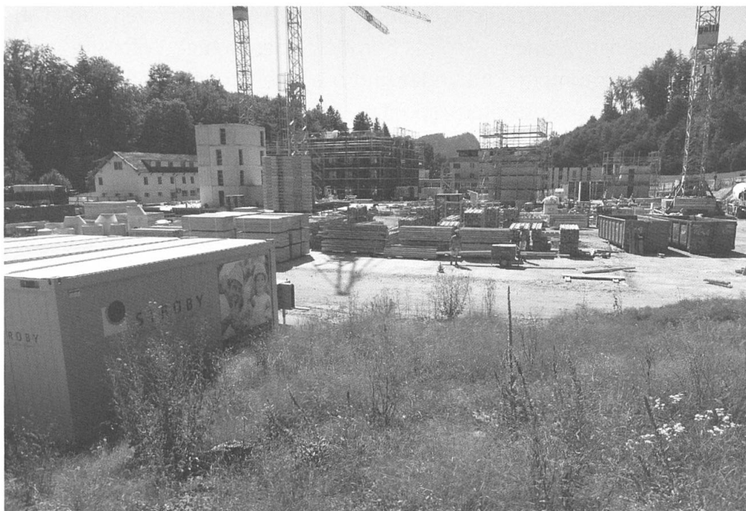
Die Strüby Immo AG aus Seewen (SZ) baut im Fischermätteli-Quartier 169 Wohnungen mit Schweizer Holz und einem Minergie-Konzept (Foto: Viktor Kälin)
