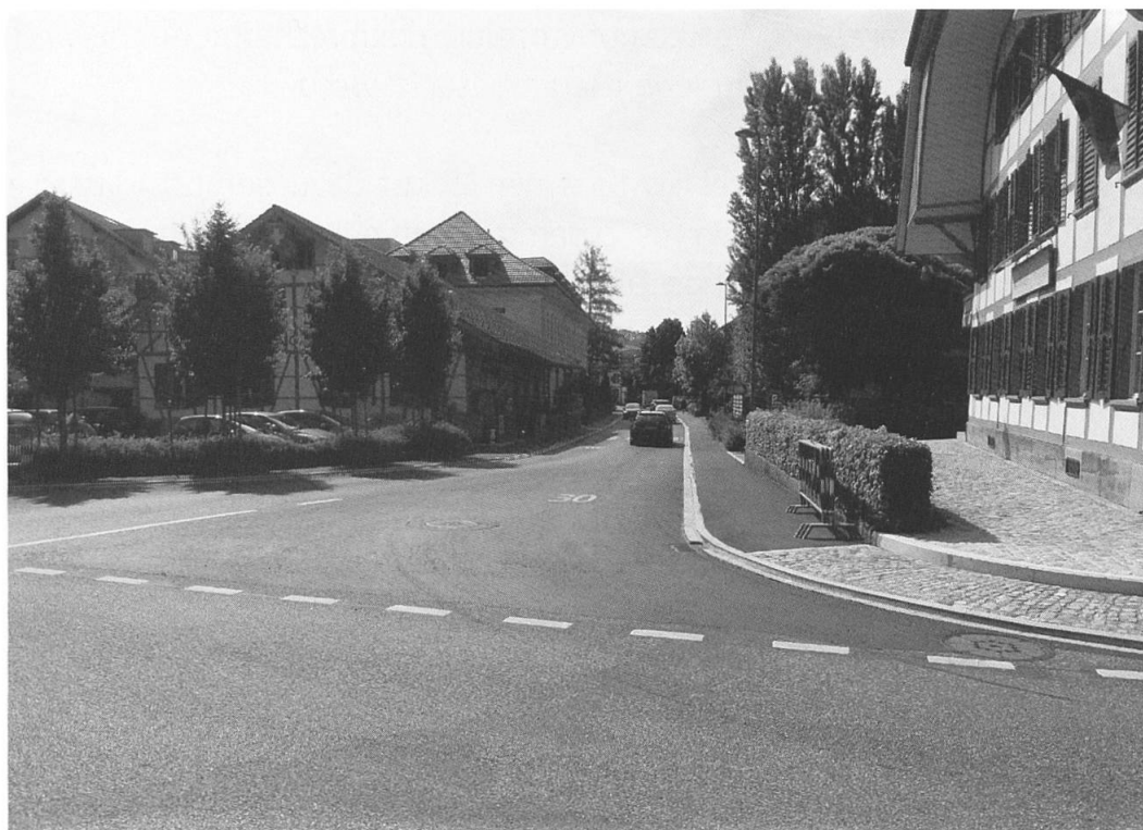
Während eines Jahres wurde die Scheunenstrasse gesamtsaniert (Foto: Viktor Kälin)
