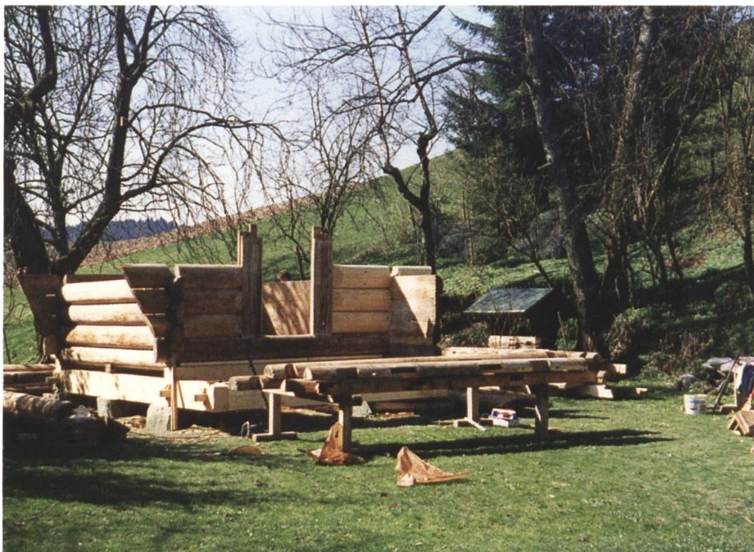
Wiederaufbau des Speichers am neuen Standort im Bannholz, Affoltern i. E.
