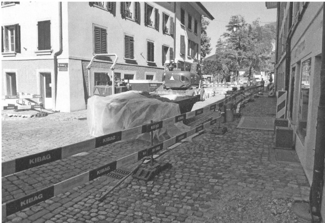
Im Mülibachgässli und in der Metzgergasse wurden alte Abwasser- und Werkleitungen ersetzt (Foto: Viktor Kälin)
