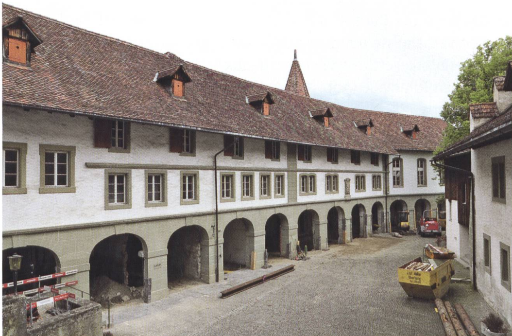
Abb. 8: Innenansicht des Schlosshofs, links das Grosse Kornhaus von 1749. Die seit dem Einbau des Gefängnisses 1885 verschlossenen Arkadenbögen wurden 2018 wieder geöffnet. Blick nach Osten (Aufnahme: Marco Amstutz ADB)
