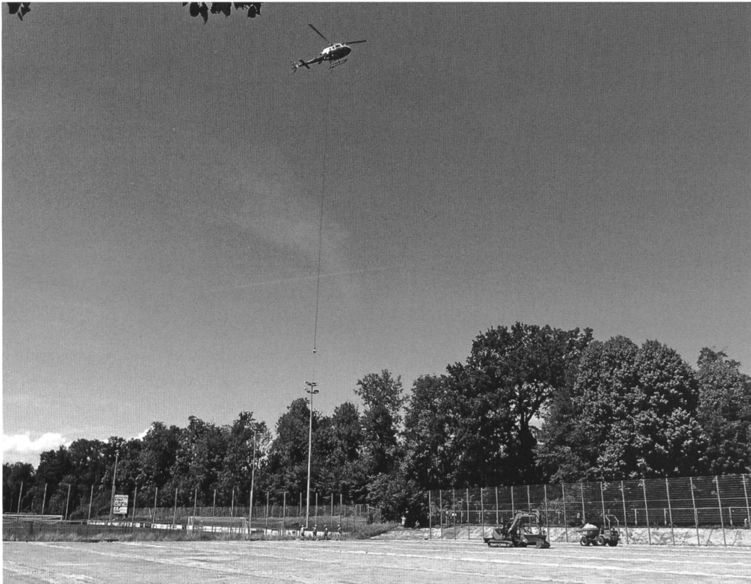
Innert 20 Minuten haben sieben Mitarbeiter mit Hilfe eines Helikopters die vier Lichtmasten auf dem neuen Fussballfeld neben dem Schulhaus Neumatt gesetzt (Foto: Viktor Kälin)
