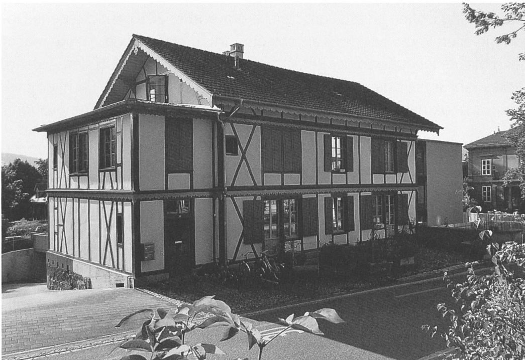
Die neue Bauherrin wurde für die sanfte Restaurierung des 1860 an der Bernstrasse erstellten Riegbaus von der Denkmalpflege geehrt (Foto: Hans Aeschlimann)
