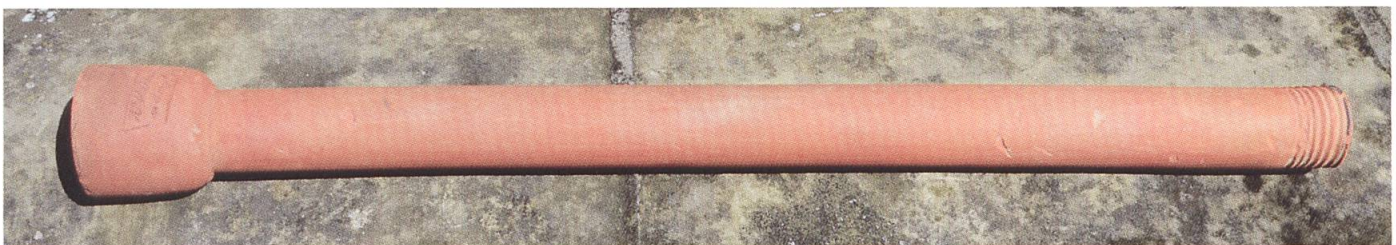
Abb. 29: Auf einer Röhrenpresse hergestelltes, vollständiges Wasserleitungsrohr aus Keramik, bezeichnet «HC h . Aeschlimann in Burgdorf». Es wurde 1996 in einer Brunnenhöhle in der Junkholzweid in Heimiswil gefunden (Foto A. Heege)
