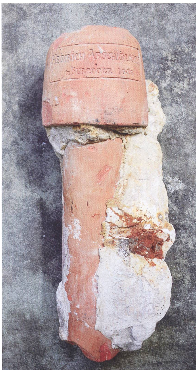
Abb. 27: Region Burgdorf, gepresstes Wasserleitungsrohr mit Muffe. Auf der Muffe Herstellerstempel «HEINRICH AESCHLIMANN IN BURGDORF, 1845» (Foto A. Heege)
