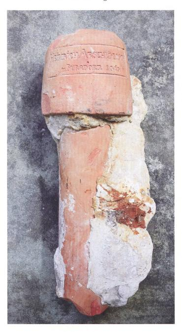
Abb. 27: Region Burgdorf, gepresstes Wasserleitungsrohr mit Muffe. Auf der Muffe Herstellerstempel «HEINRICH AESCHLIMANN IN BURGDORF, 1845» (Foto A. Heege)
