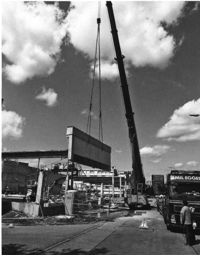
Von März bis August 2015 haben Spezialfirmen die alte Shedhalle der ESA an der Maritzstrasse zurückgebaut. Der Kran kann 35 Tonnen heben
