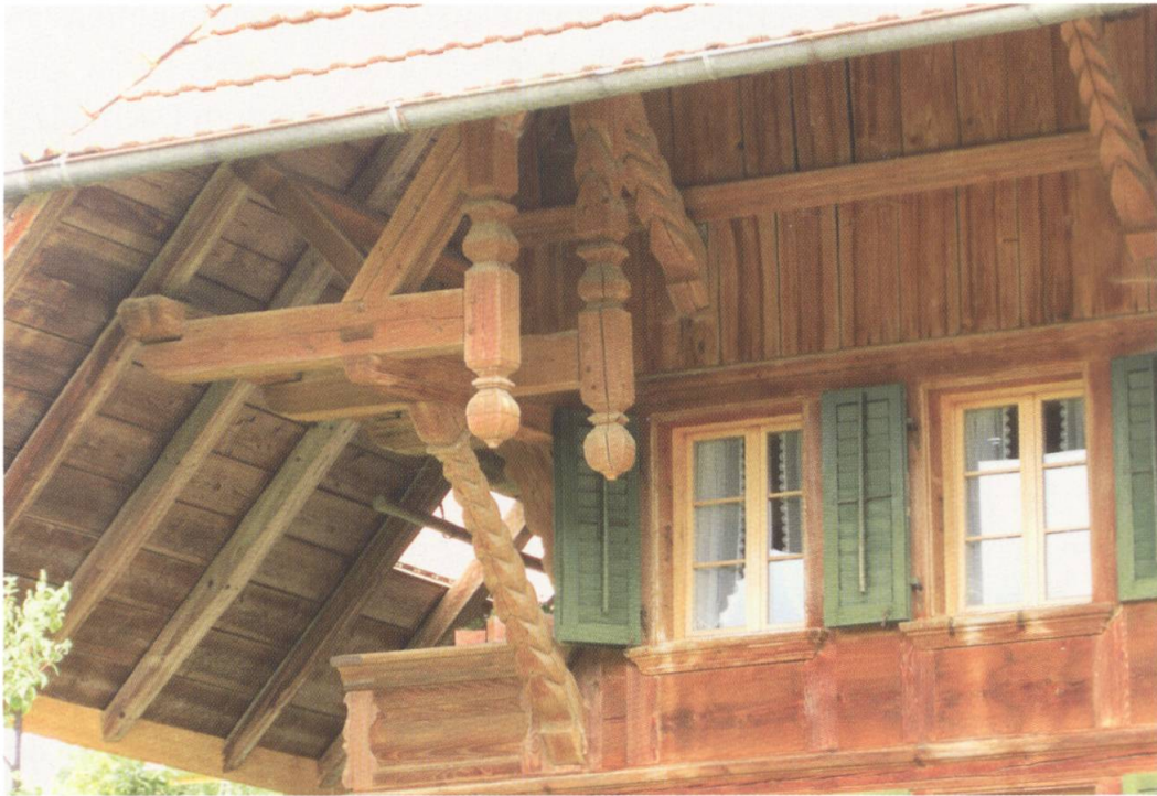
Doppelte Freibünde sichern Vordach ab
