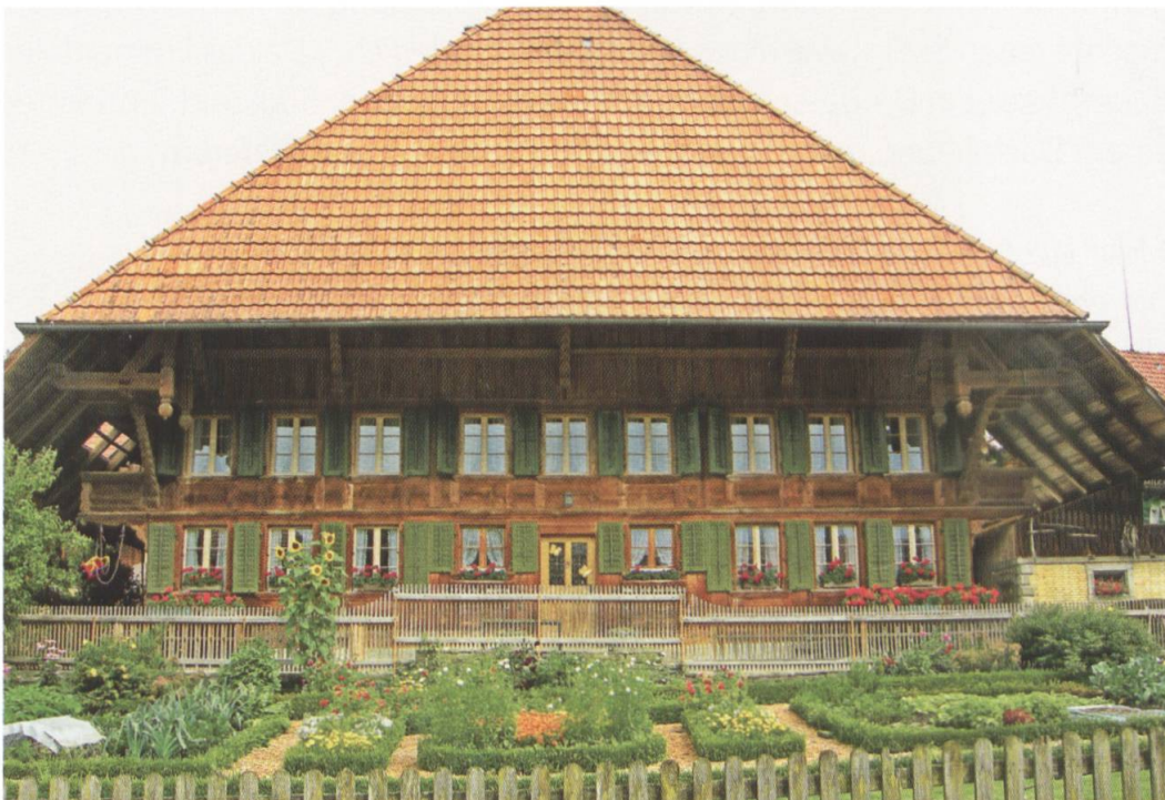
Neunachsiger Ständerbau mit Halbwalmdach, datiert 1793, erneuert 1921
