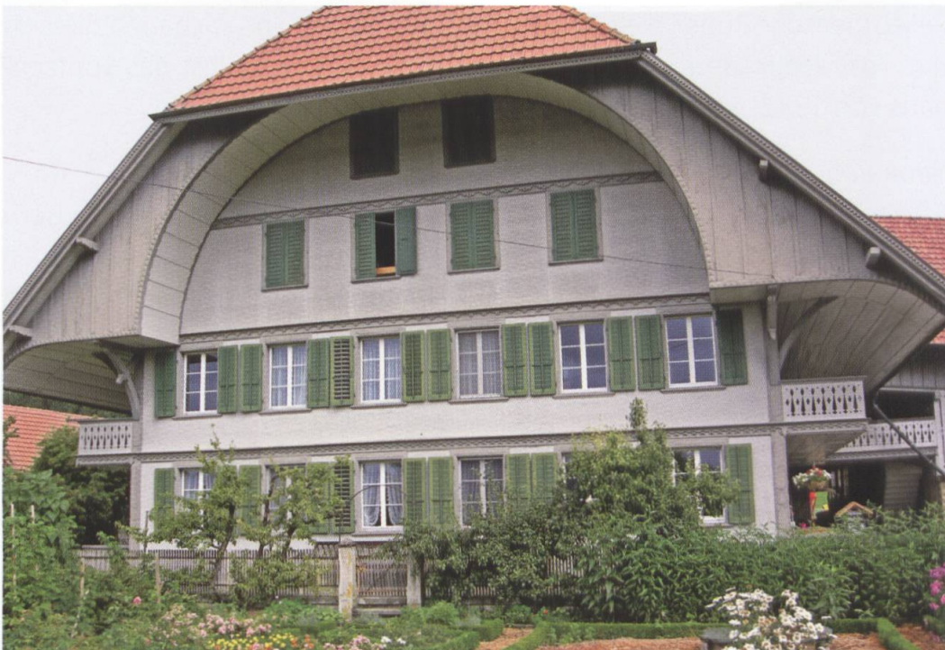
Ründer bringt Licht in die Gaden und ins Bühnengeschoss. Neubau von 1901
