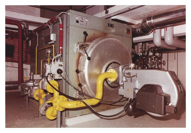
Neue Heizsysteme: Kessel mit Zweistoffbrenner Erdgas/Heizöl EL, ca. 1985
