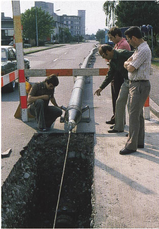
Einbau von neuem Gasleitungsmaterial – Reliningverfahren – an der Kirchbergstrasse, 1976
