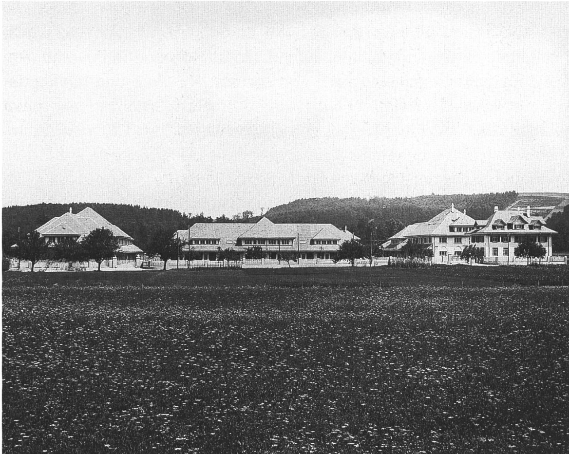
Das Zeughausareal an der Kirchbergstrasse (Foto: Louis Bechstein)
