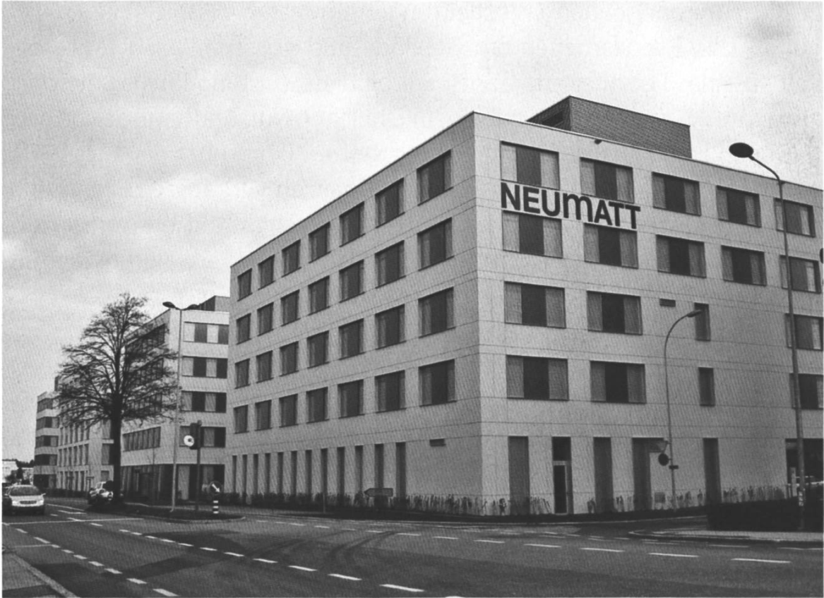
Der Gebäudekomplex an der Kirchbergstrasse
