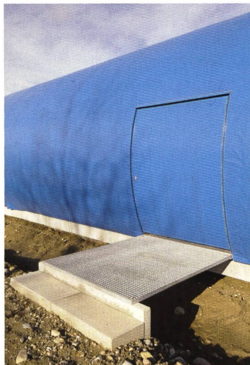
Eine Notausgangstüre an der Fassade (runde Türen bieten immer gewisse technische Probleme!)
