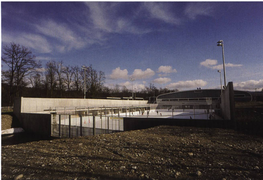
Hier ist gut zu erkennen, dass auch das Ausseneisfeld in den Boden versenkt wurde
