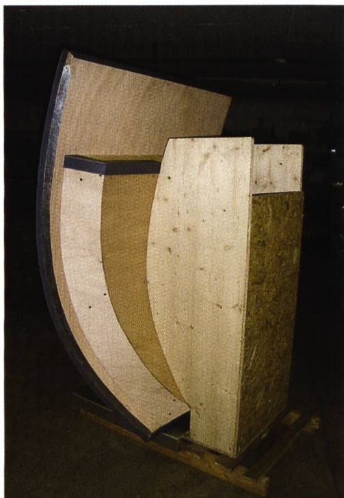
Dieses Modell 1:1 zeigt den Aufbau der Fassadenkonstruktion
