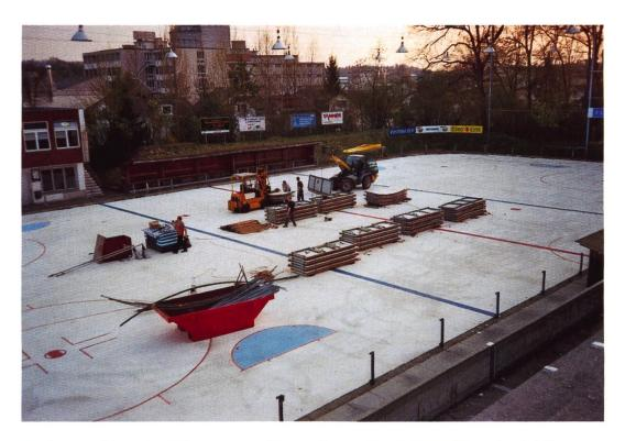
Beginn Rückbau der KEB-Anlage: Abmontieren der Kunststoffbanden 2010
