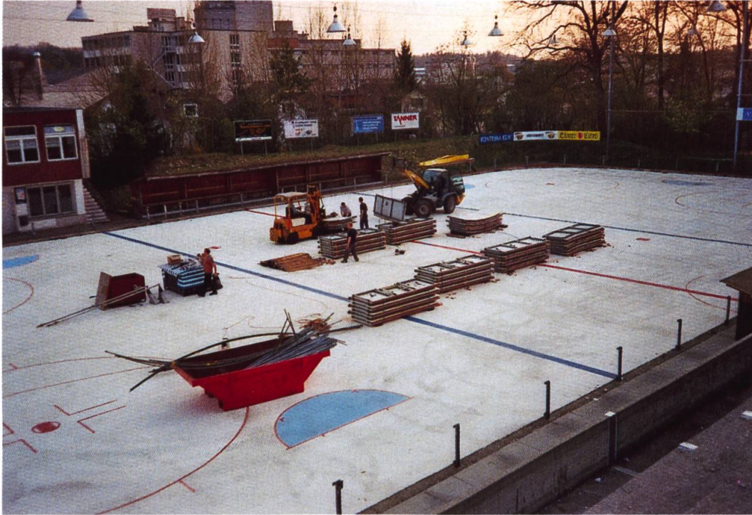
Beginn Rückbau der KEB-Anlage: Abmontieren der Kunststoffbanden 2010
