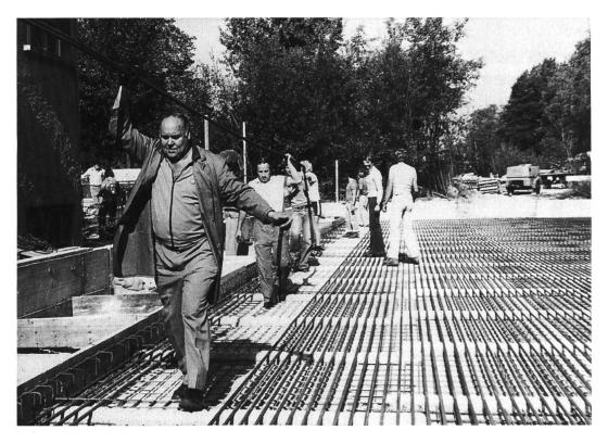
Beim Verlegen der Kühlrohre für die 1976 erstellte, separate Curlingbahn
