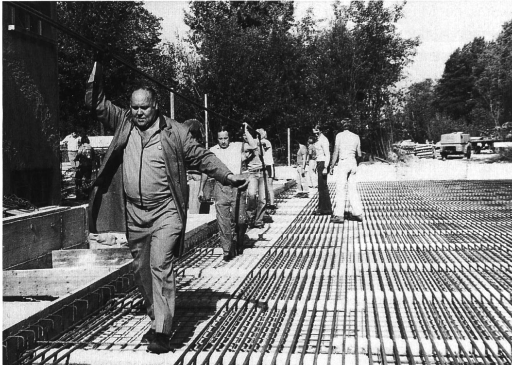
Beim Verlegen der Kühlrohre für die 1976 erstellte, separate Curlingbahn
