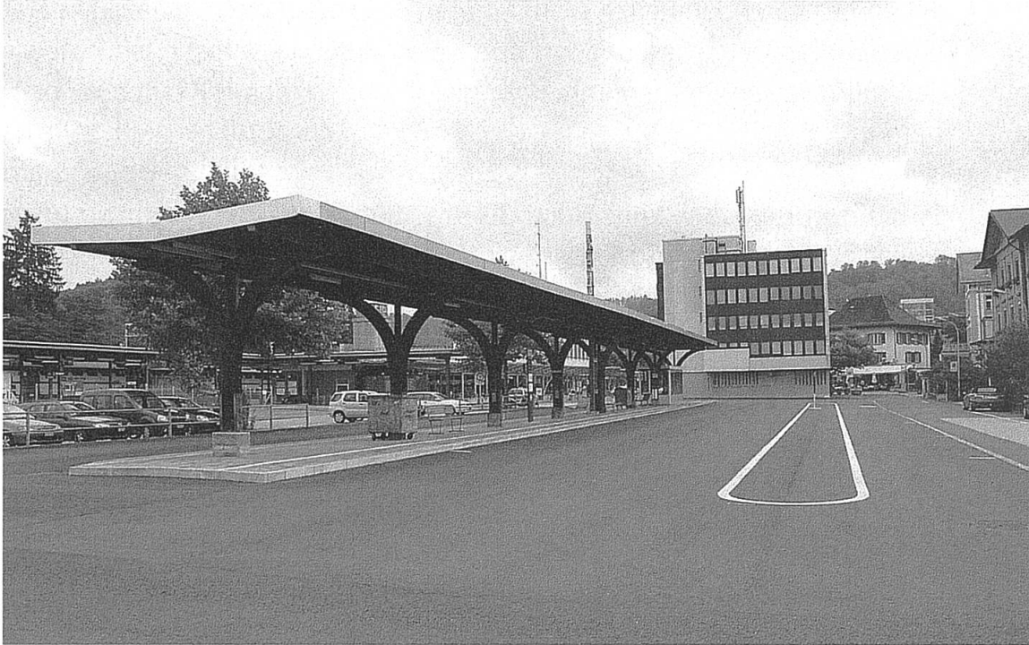
Die neue, als Provisorium gedachte Busstation auf dem Areal des früheren EBT-, RM- und BLS-Bahnhofs ist seit Anfang Mai 2009 in Betrieb
