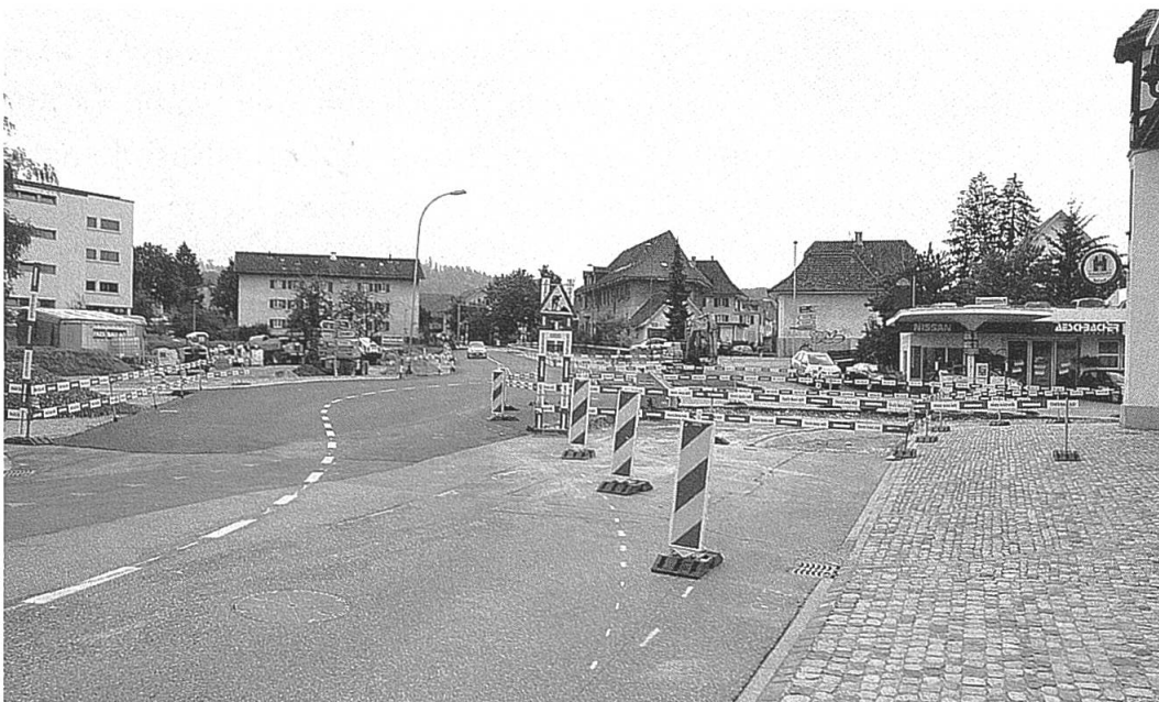
Ab Juli 2009 ist der Umbau der viel befahrenen National-Kreuzung zu einem grossen Kreislauf in vollem Gang
