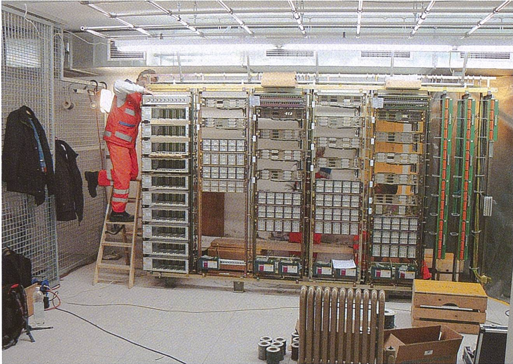
Neues elektronisches Stellwerk: Montagearbeiten, Anfang 2008
