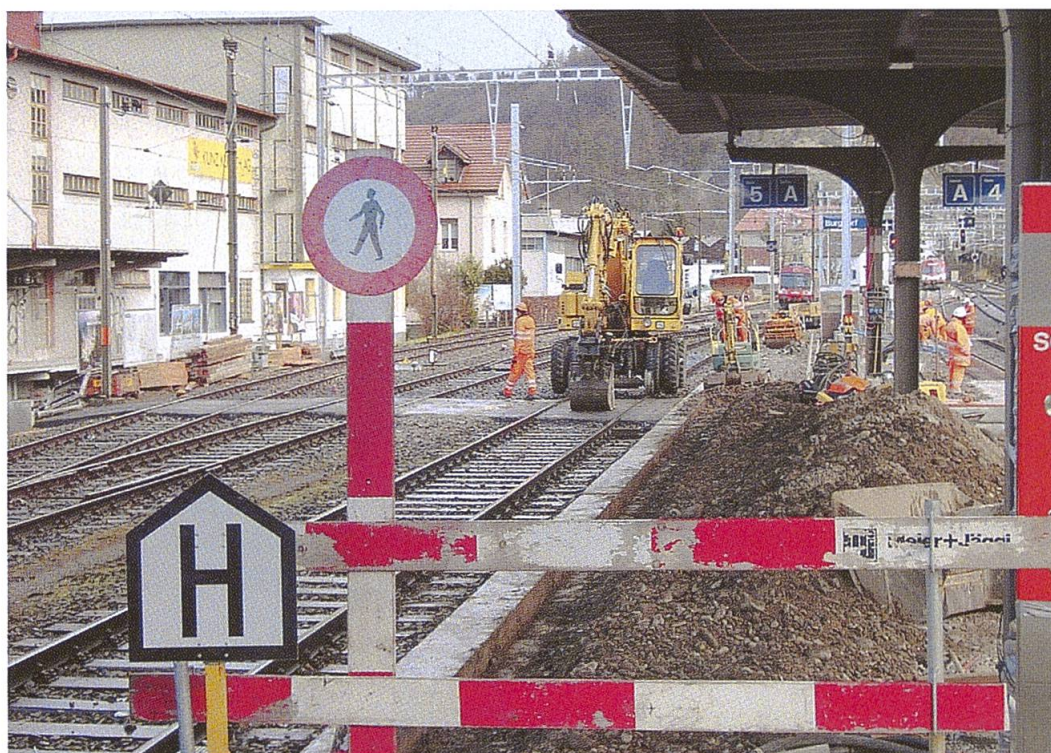
Arbeiten für die Perronerhöhung des Perrons Gleise 4/5
