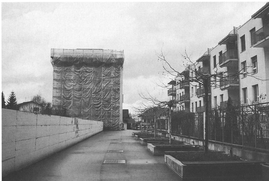
Während langer Zeit war er eingerüstet und mit Blachen abgedeckt, der «Doppelturm» im Steinhof, der an die dortige ehemalige Brauerei erinnert. Nun soll die zweite Etappe der Überbauung in Angriff genommen werden
