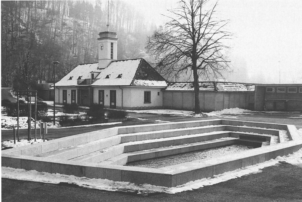
Im Rahmen des Projekts Renaturierung der Kleinen Emme ist der Platz zwischen Freibad und Hallenbad neu gestaltet worden
